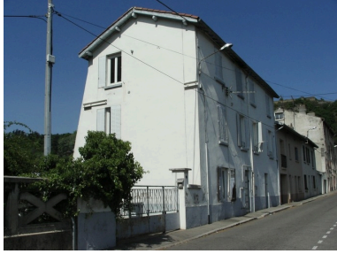
façade ouest et sud est Phot. Benoît Chapelle IVR82_20073800060NUCA
