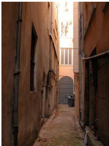
Elévation sur l'impasse, partie inférieure Phot. Phot. Inv. D. Chevallier IVR82_20046900616NUCA
