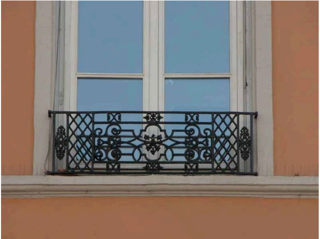
Façade sur le quai, détail d'un garde-corps de fenêtre
