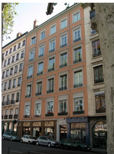
Façade sur le quai, vue générale Phot. Phot. Inv. D. Chevallier IVR82_20046900614NUCA
