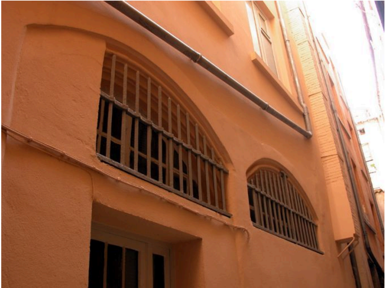
Deuxième corps de bâtiment, façade sur l'impasse, arcs du rez-de-chaussée
