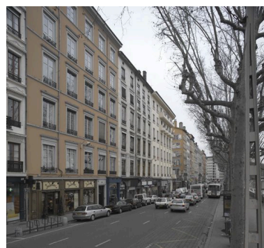
Façade sur le quai, vue générale du côté gauche Phot. Eric Dessert IVR82_20056900409NUC
