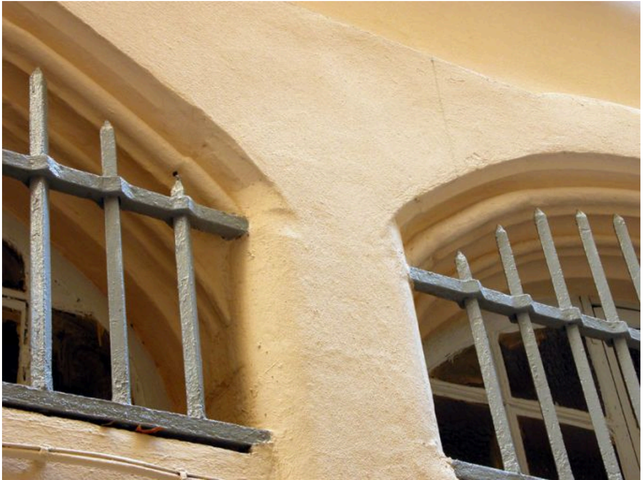
Deuxième corps de bâtiment, façade sur l'impasse, arcs du rez-de-chaussée, détail
