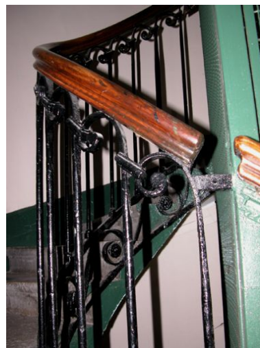
Escalier, détail de la rampe Phot. Bernard Ducouret IVR82_20046900623NUCA
