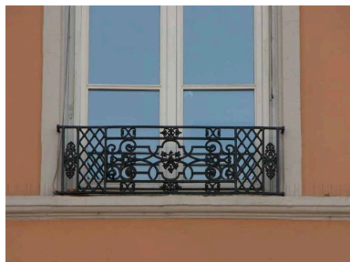
Façade sur le quai, détail d'un garde-corps de fenêtre Phot. Phot. Inv. D. Chevallier IVR82_20046900615NUCA
