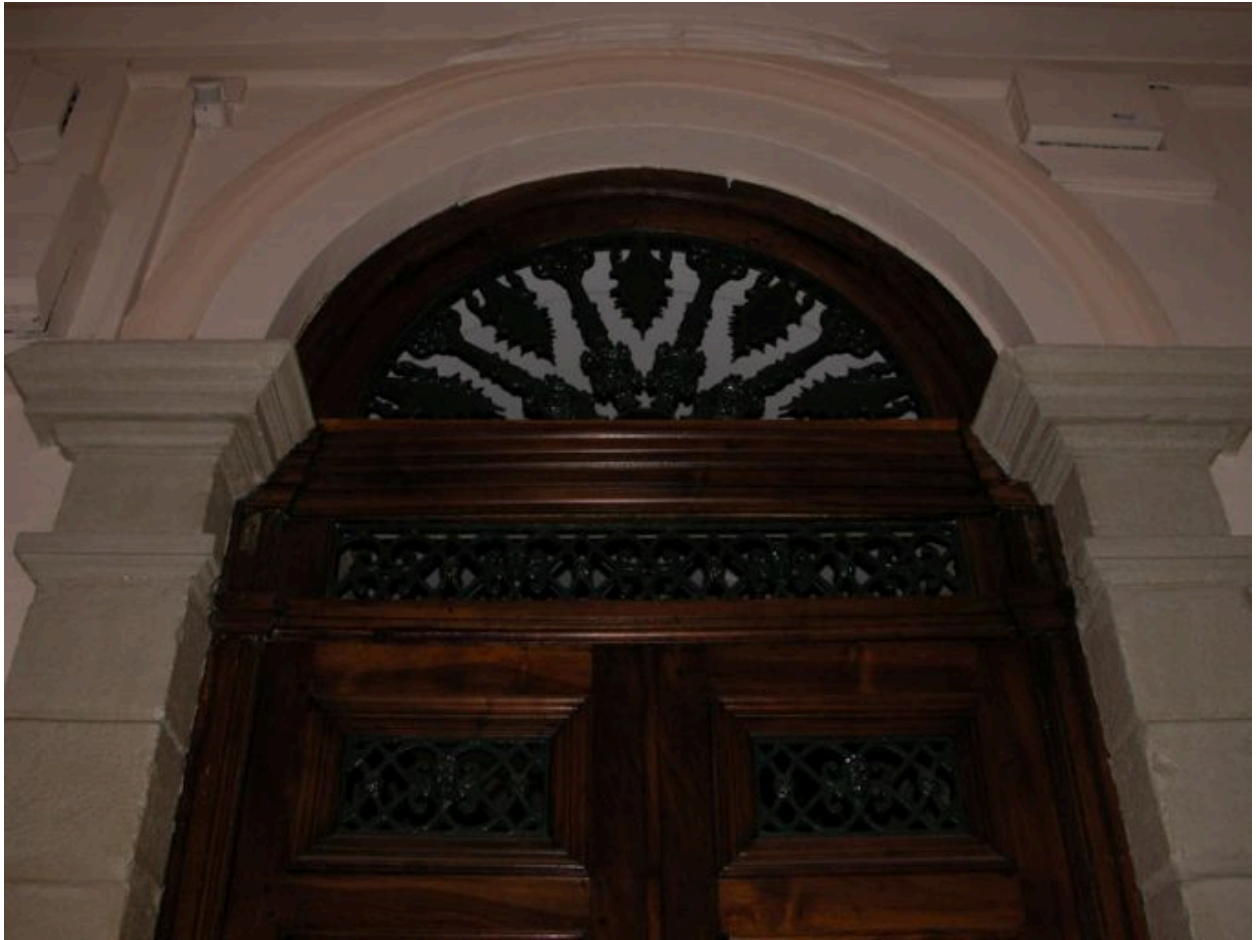
Passage, porte de l'escalier, détail
