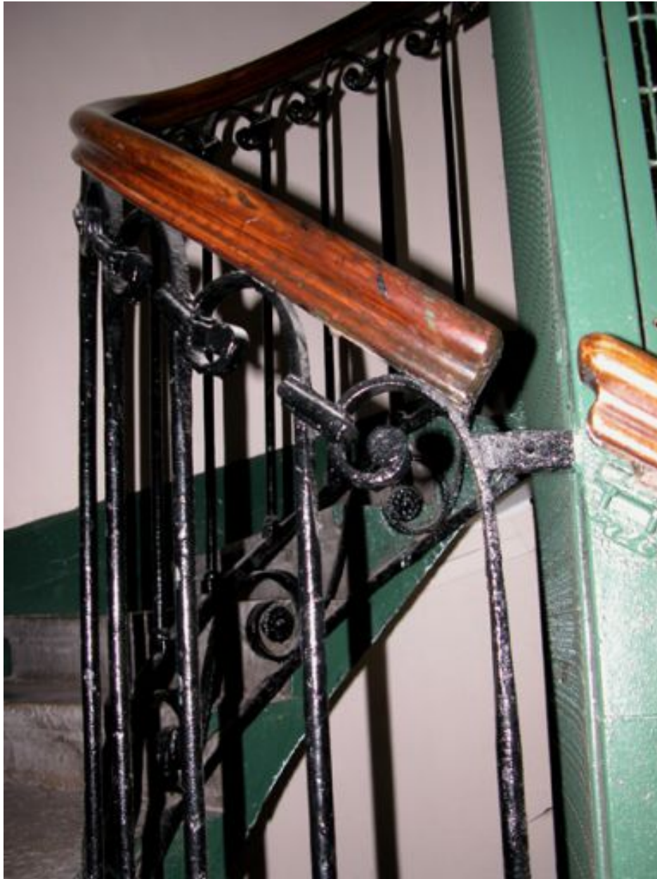
Escalier, détail de la rampe
