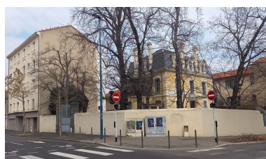
Elévation aveugle du n°21 avenue d'Italie en surplomb du jardin du n°23 avenue Charras Phot. Félicie Fougère IVR84_20236300291NUC4A
