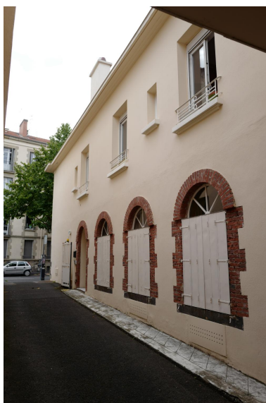
Allée longeant le n°17 bis avenue d'Italie Phot. François-Nicolas L'Hardy IVR84_20246300120NUCA
