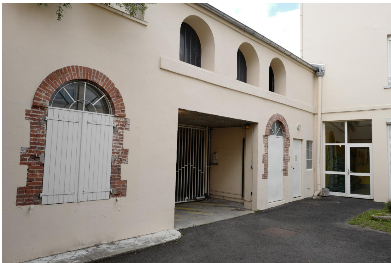
Elévation sur cour, 17 bis avenue d'Italie
