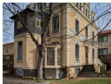
Angle des élévations Phot. Christian Parisey IVR84_20246300163NUC4A
