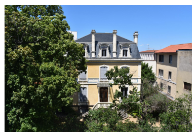
Elévation principale sur l'avenue Charras Phot. Félicie Fougère IVR84_20246300045NUCA
