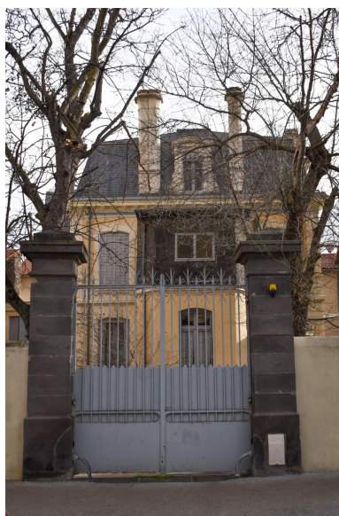
Portail sur l'avenue d'Italie Phot. Félicie Fougère IVR84_20246300097NUCA
