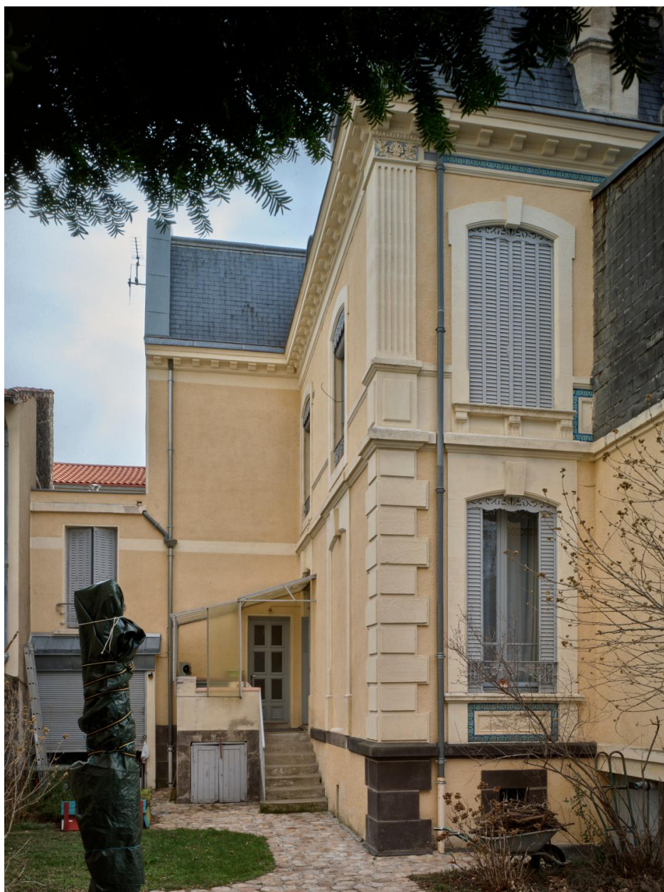
Elévation postérieure, accès à l'escalier
