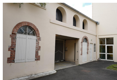
Elévation sur cour, 17 bis avenue d'Italie Phot. François-Nicolas L'Hardy IVR84_20246300122NUCA
