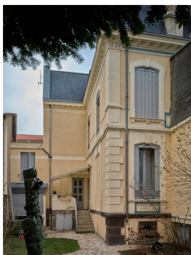
Elévation postérieure, accès à l'escalier Phot. Christian Parisey IVR84_20246300164NUC4A
