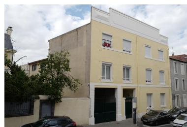
Elévation sur l'avenue Charras Phot. François-Nicolas L'Hardy IVR84_20246300030NUCA
