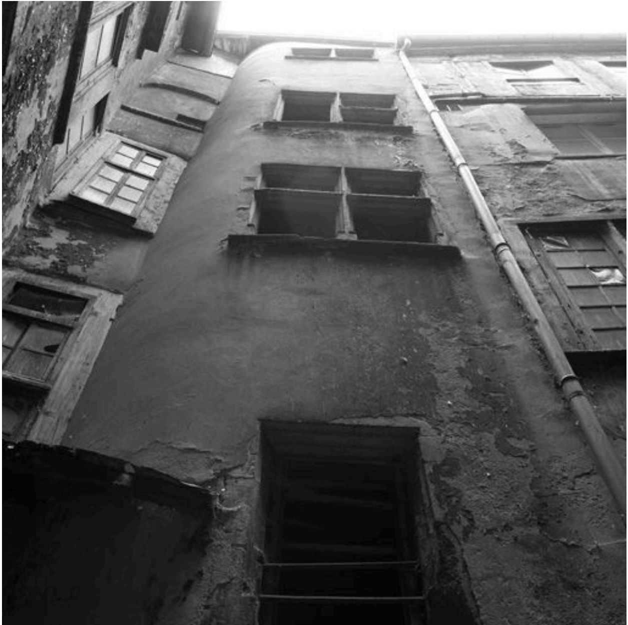
Bâtiment 3, élévation de l'escalier sur la cour III et galeries de liaison avec le bâtiment 4
