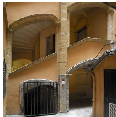
Cour I, élévation de l'escalier, partie inférieure
