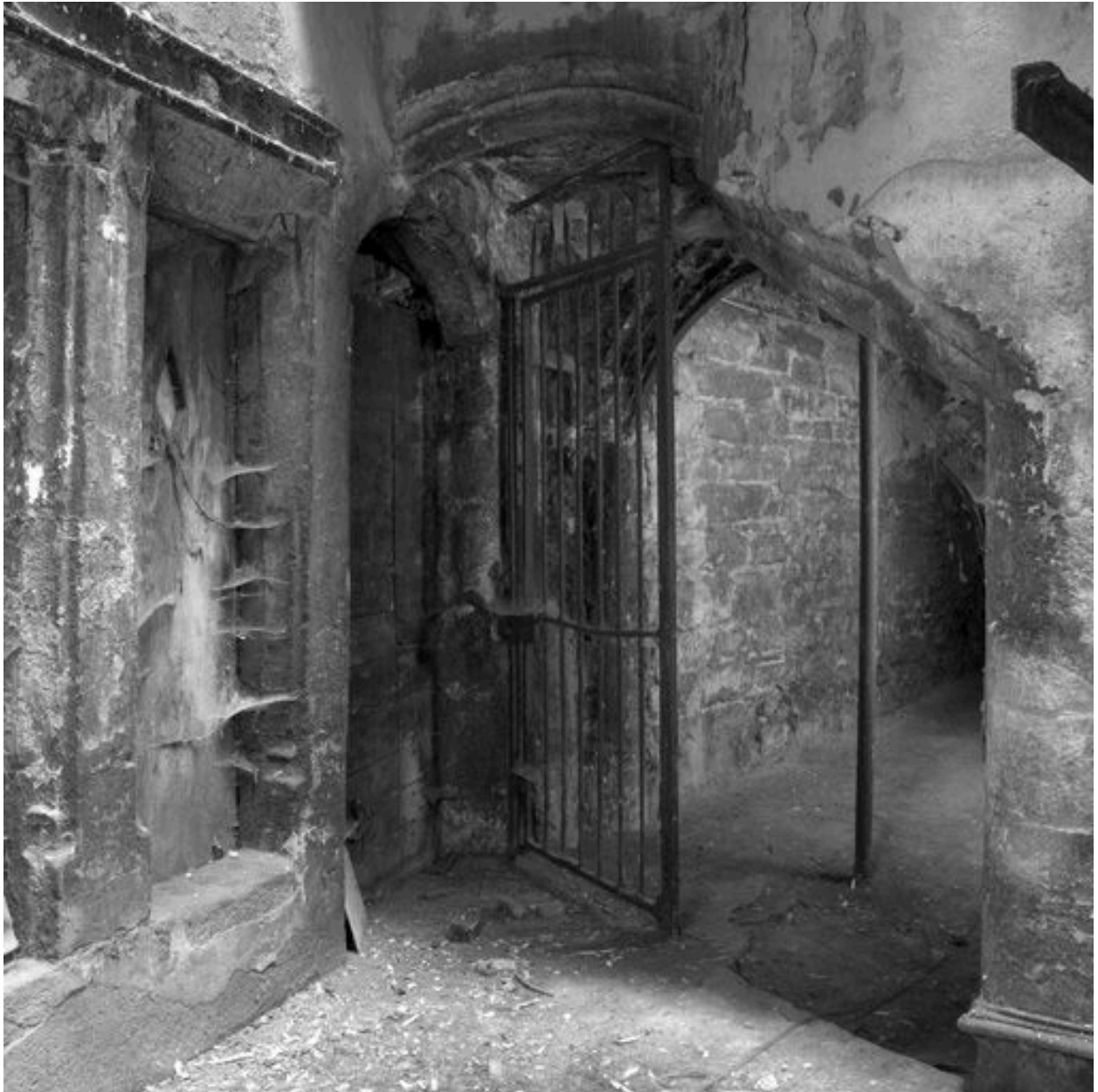
Bâtiment 3, détail du rez-de-chaussée de la cage d'escalier et allée
