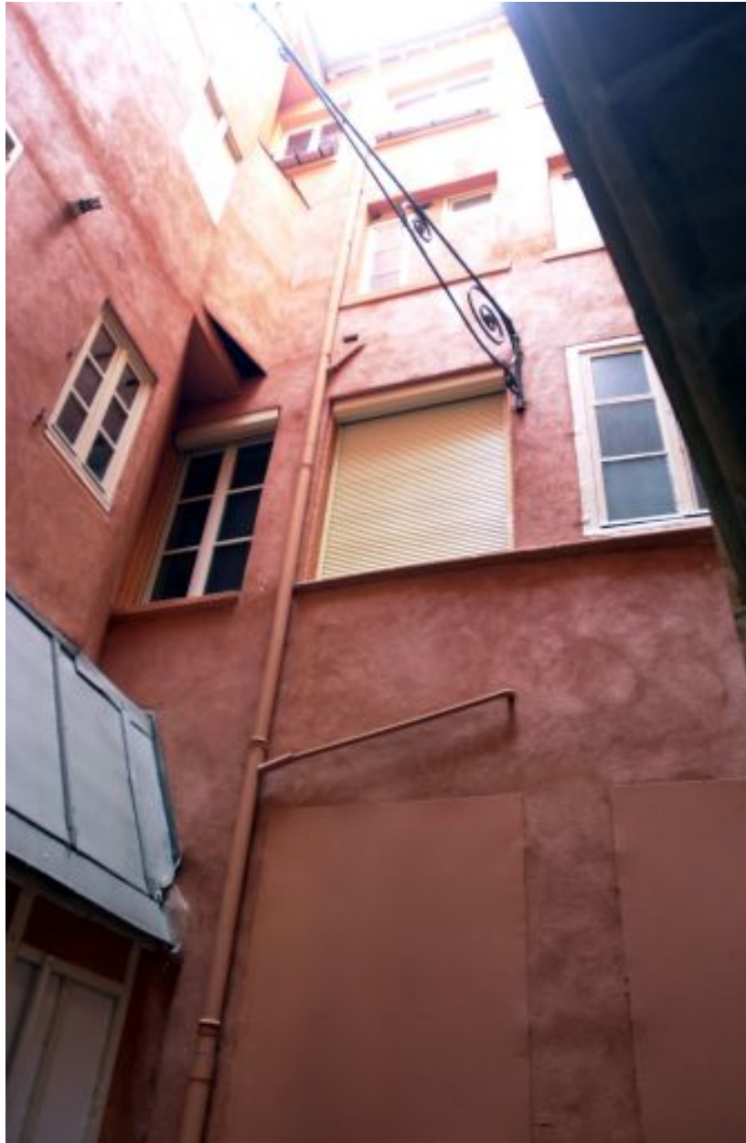
Cour I, élévation du bâtiment 2
