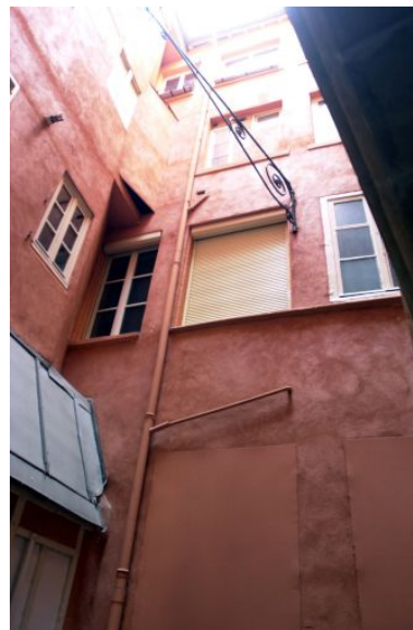
Cour I, élévation du bâtiment 2 Phot. Bernard Ducouret IVR82_20036901488NUCA
