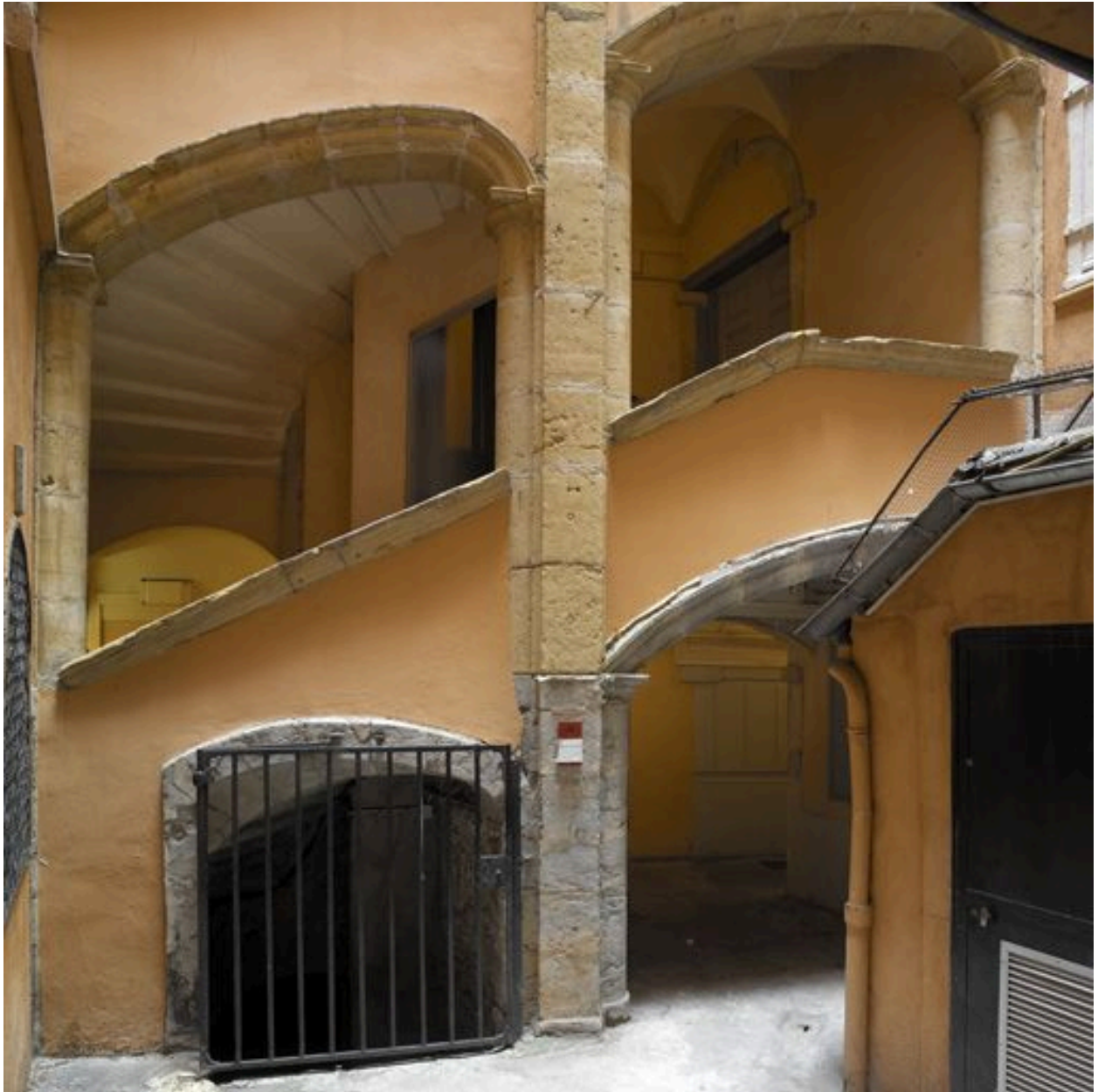
Cour 1, élévation de l'escalier, partie inférieure
