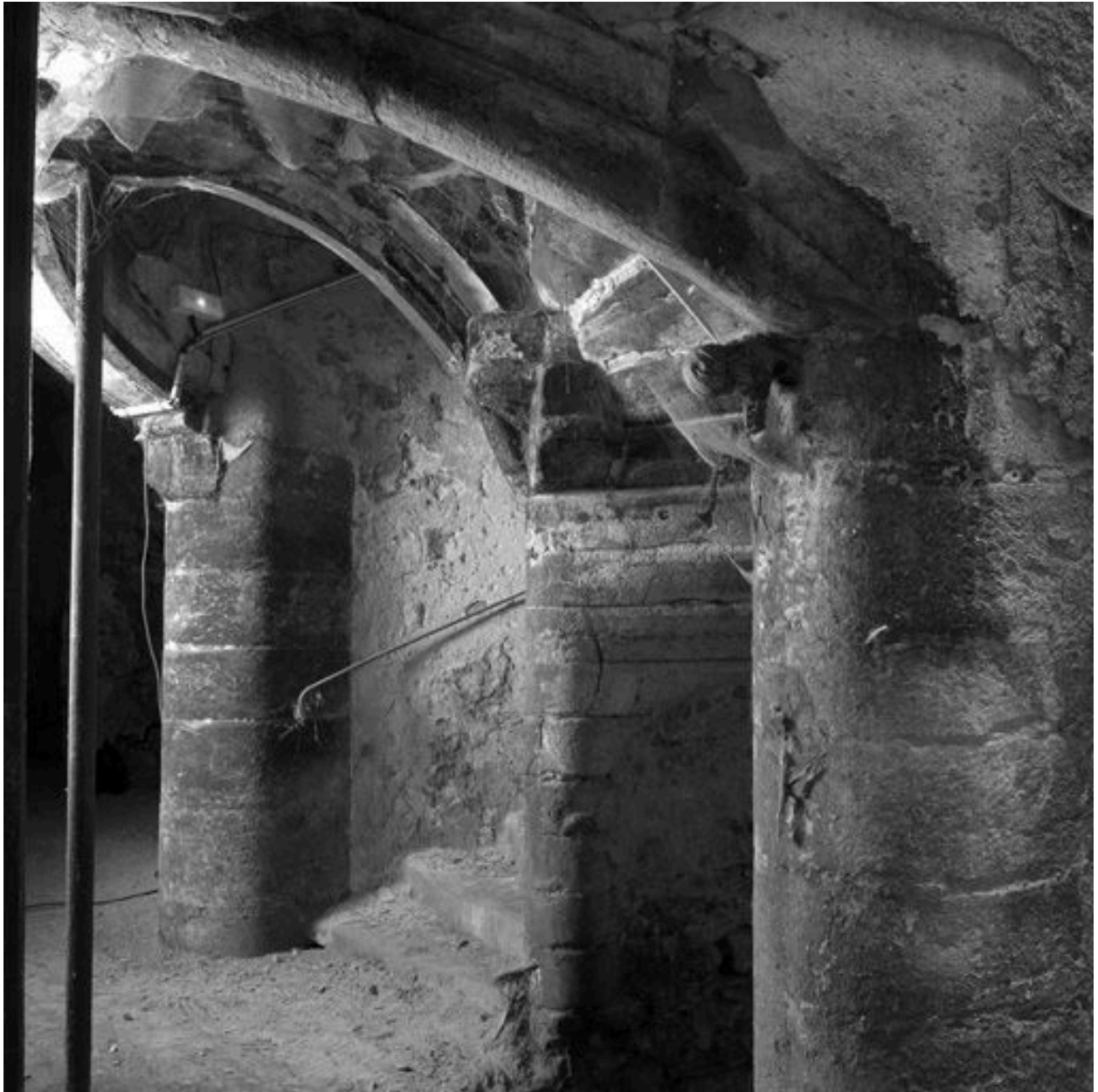
Escalier du bâtiment 3, départ
