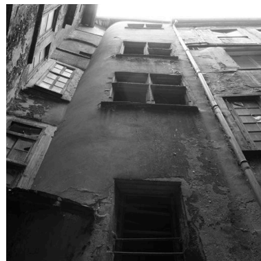
Bâtiment 3, élévation de l'escalier sur la cour III et galeries de liaison avec le bâtiment 4 Phot. Didier Gourbin IVR82_20056901495NUC
