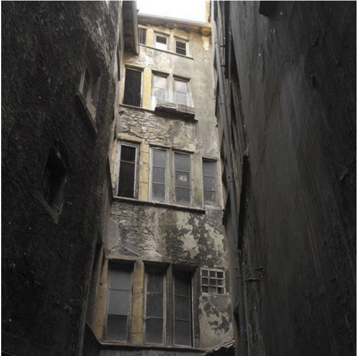
Bâtiment 4, vue des niveaux 2 à 5
