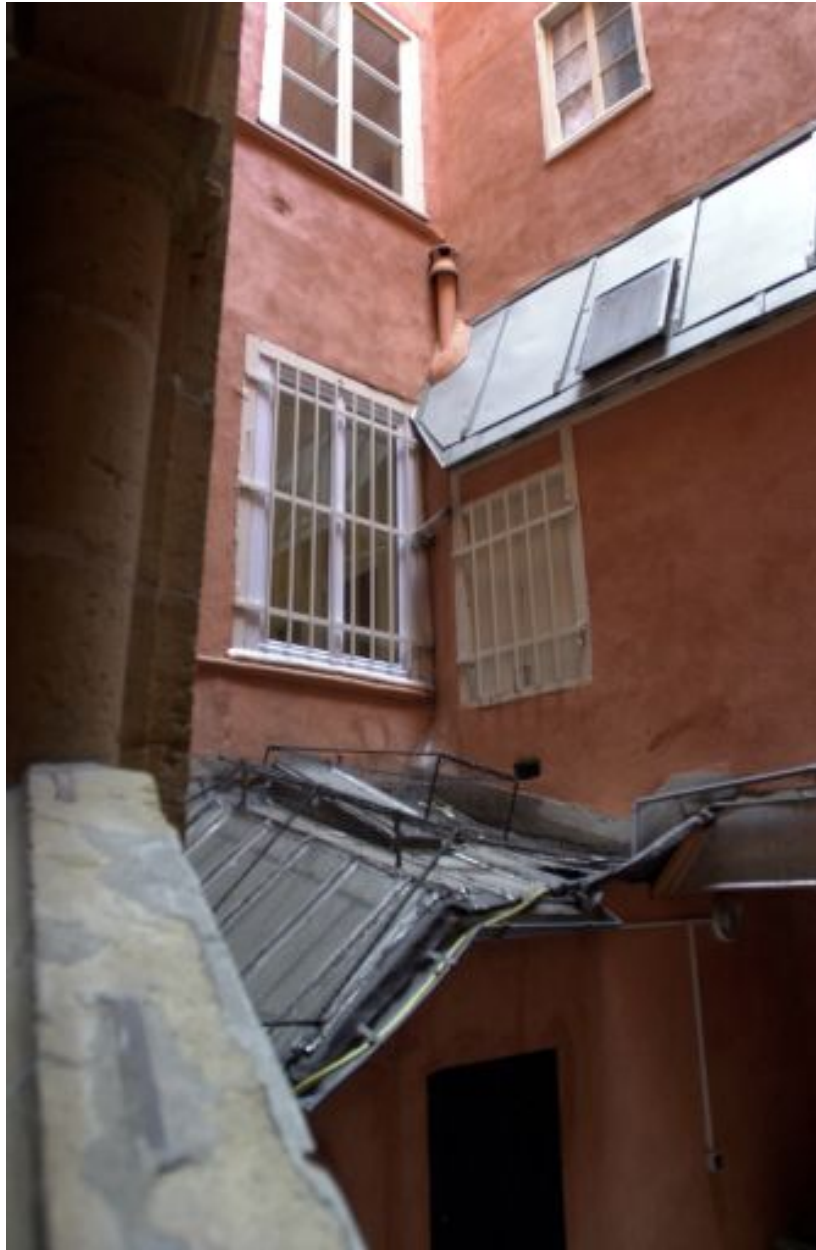
Cour I, bâtiment 1, détail du premier étage
