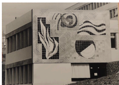
Lycée Aubenas, administration, panneau décoratif, 1965 (AN 20020101/4). Autr. auteur inconnu, Repro. Elisabeth Dandel IVR84_20200700012NUCB
