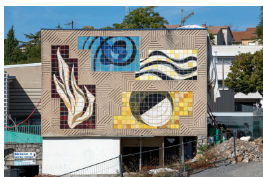
Vue d'ensemble. Phot. Michel Pérès IVR84_20200700098NUCA
