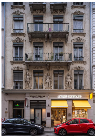
Vue générale Phot. Michel Pérès IVR84_20236900567NUCA
