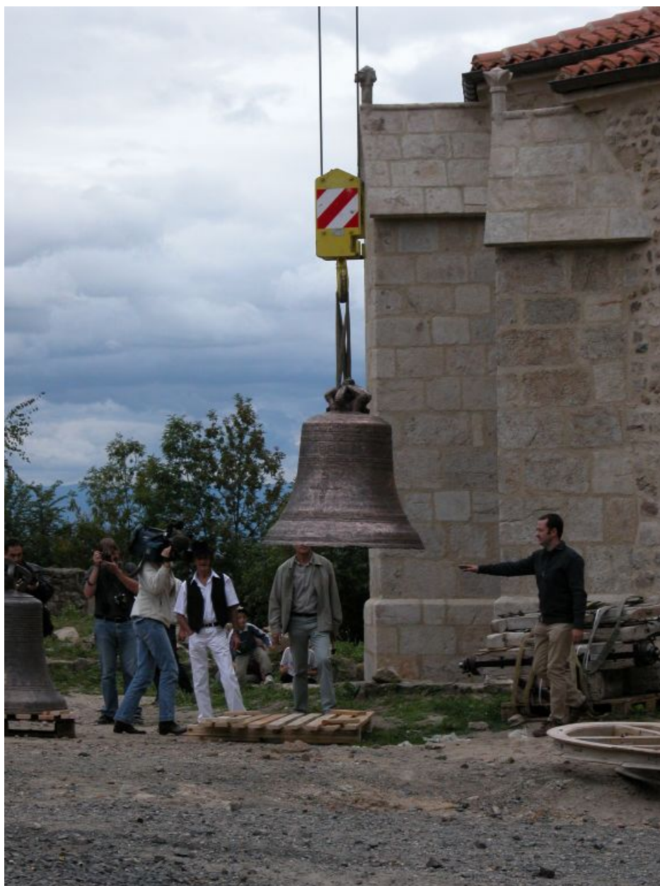
Enlèvement de la cloche (n°1) pour être déposée dans le clocher.
