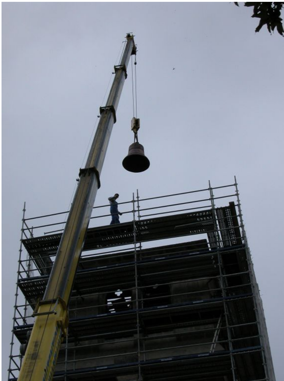
Cloche (n°1) élevée à l'aide d'une grue jusqu'au sommet du clocher pour y être installée.
