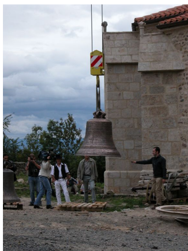
Enlèvement de la cloche (n°1) pour être déposée dans le clocher. Phot. Thierry Monnet IVR82_20094200146NUCA
