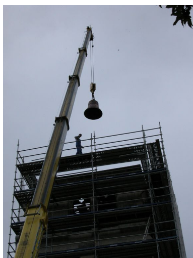
Cloche (n°1) élevée à l'aide d'une grue jusqu'au sommet du clocher pour y être installée. Phot. Thierry Monnet IVR82_20094200149NUCA
