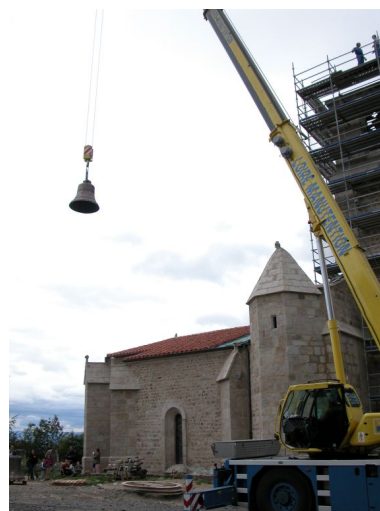
Cloche (n°1) élevée à l'aide d'une grue. Phot. Thierry Monnet IVR82_20094200148NUCA
