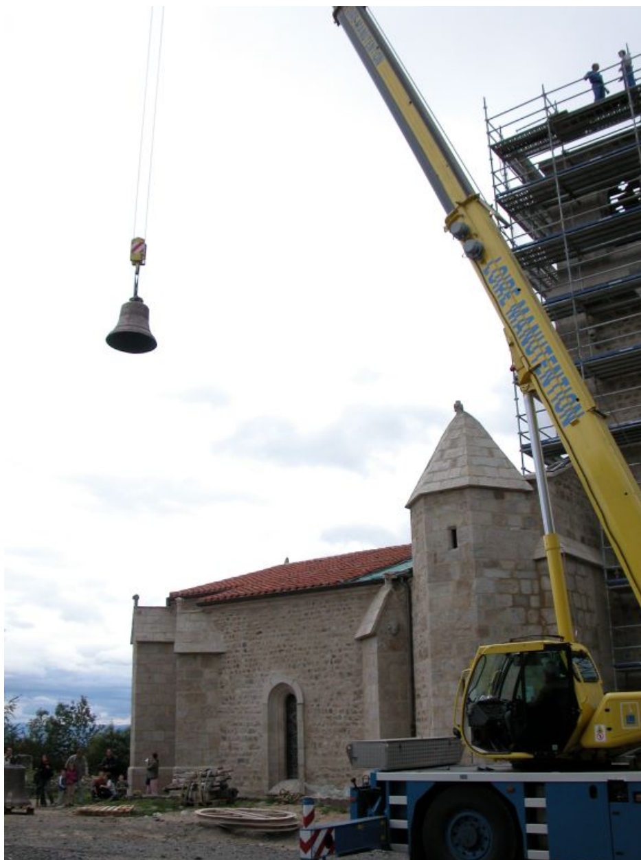
Cloche (n°1) élevée à l'aide d'une grue.
