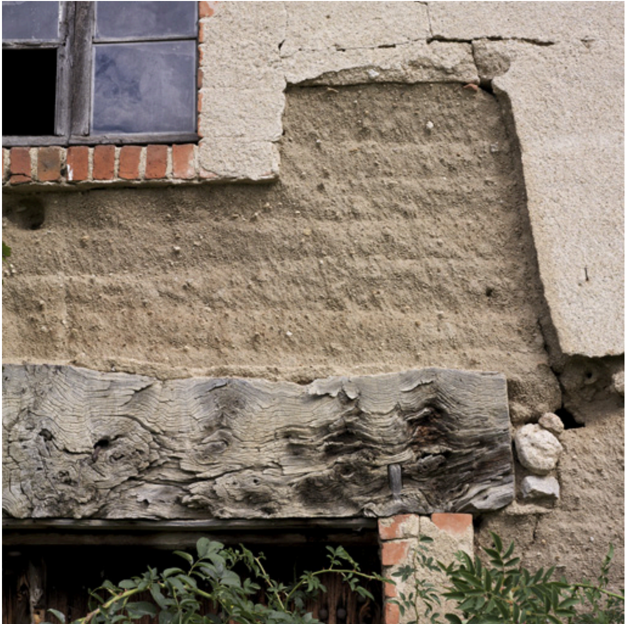
Détail de matériaux.
