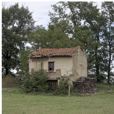
Vue générale. Phot. Eric Dessert IVR82_20074200972NUCA
