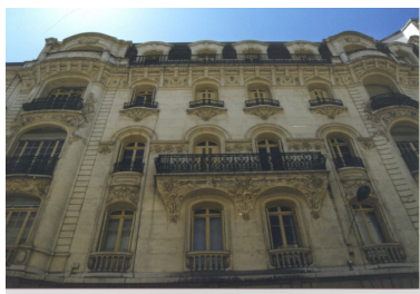
Façade principale. Détail Phot. Cendrine Sanquer IVR82_19974202009ZE
