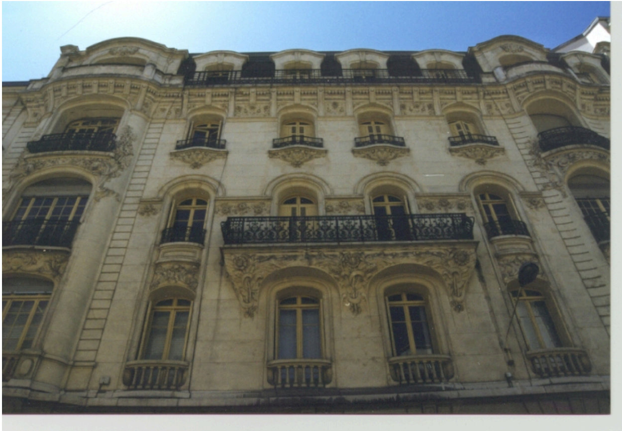
Façade principale. Détail
