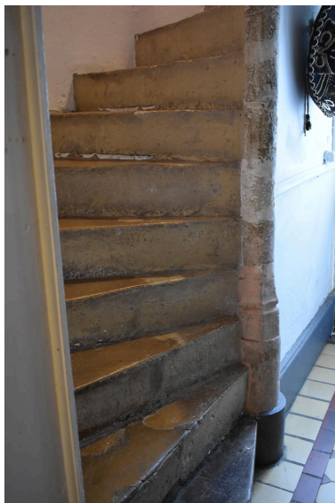
Vue de l'escalier en vis. Phot. Maryse Durin-Tercelin IVR84_20250300560NUC4A
