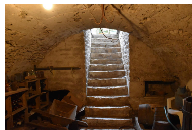
Détail de l'escalier d'accès à la cave. Phot. Maryse Durin-Tercelin IVR84_20250300564NUC4A
