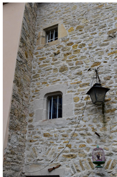
Détail des baies éclairant l'escalier en vis au sud-est. Phot. Maryse Durin-Tercelin IVR84_20250300558NUCA4A
