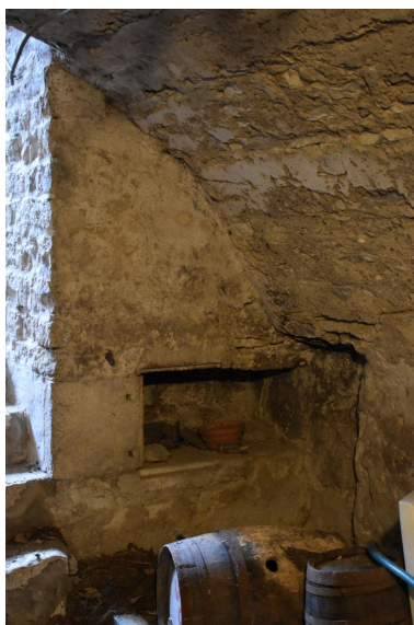
Détail d'une niche dans la cave. Phot. Maryse Durin-Tercelin IVR84_20250300563NUC4A
