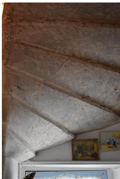
Détail de l'escalier en vis, vue de dessous. Phot. Maryse Durin-Tercelin IVR84_20250300562NUC4A
