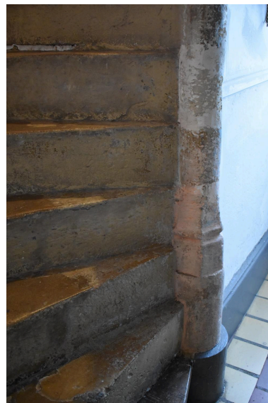
Détail du noyau de l'escalier en vis. Phot. Maryse Durin-Tercelin IVR84_20250300561NUC4A
