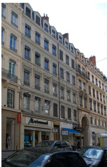
Vue de l'élévation antérieure Phot. Catherine Guégan IVR82_20086901525NUCA
