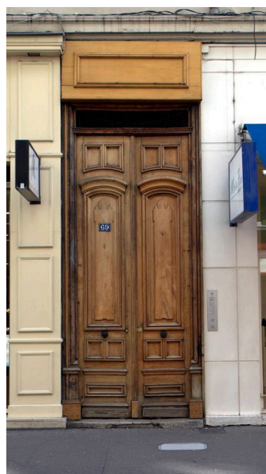
Elévation antérieure, détail de la porte Phot. Catherine Guégan IVR82_20096900538NUCA
