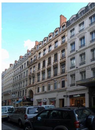
Vue d'ensemble des immeubles 69 et 71 rue du Président- Edouard-Herriot depuis le sud Phot. Catherine Guégan IVR82_20086903018NUCA
