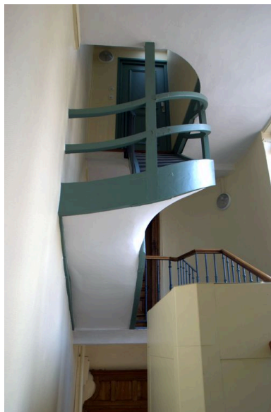
Vue de la dernière volée de l'escalier, en bois Phot. Catherine Guégan IVR82_20086901528NUCA
