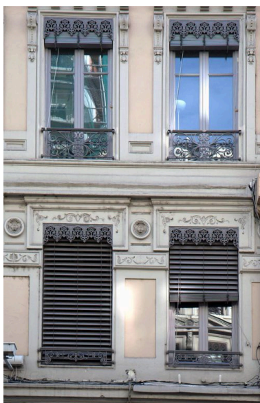
Elévation antérieure, détail des baies de l'entresol et du 1er étage Phot. Catherine Guégan IVR82_20096900539NUCA
