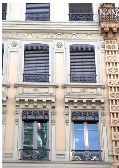
Elévation antérieure, détail des baies des 1er et 2e étages Phot. Catherine Guégan IVR82_20086901526NUCA
