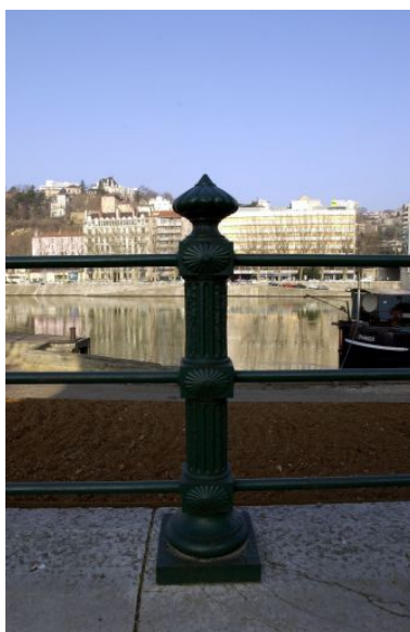
Détail d'un balustre du garde-corps Phot. Maryannick Chalabi IVR82_20016900351NUCA
