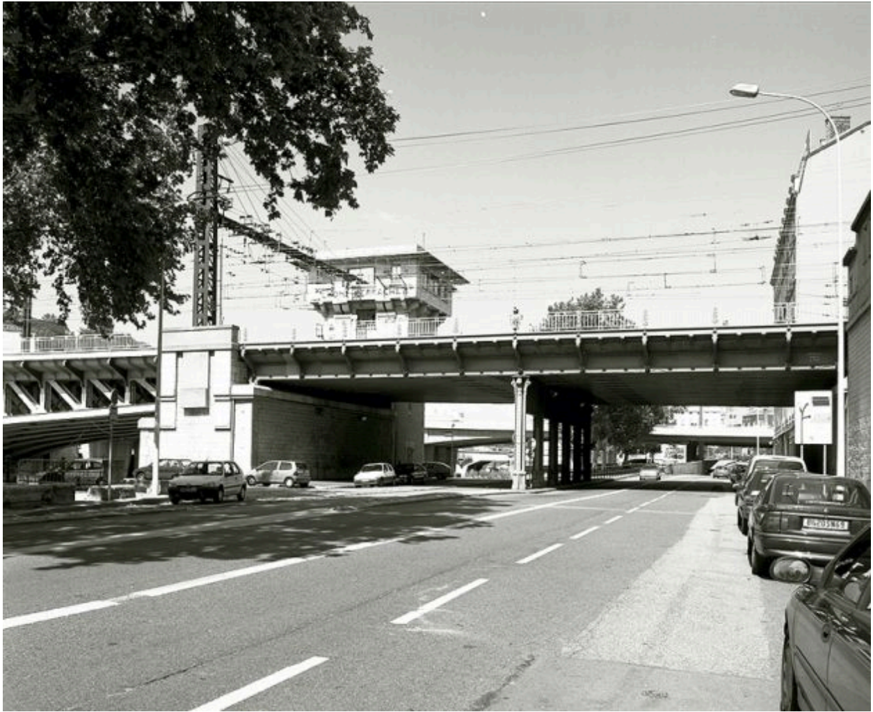
Vue d'ensemble depuis le sud, à la hauteur du pont ferroviaire
