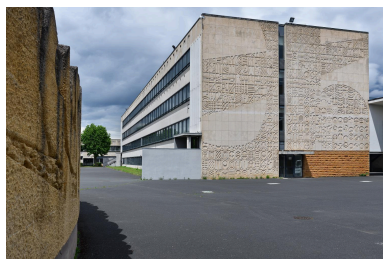
Vue du pignon revêtu. Phot. Michel Pérès IVR84_20216900779NUCAQ
