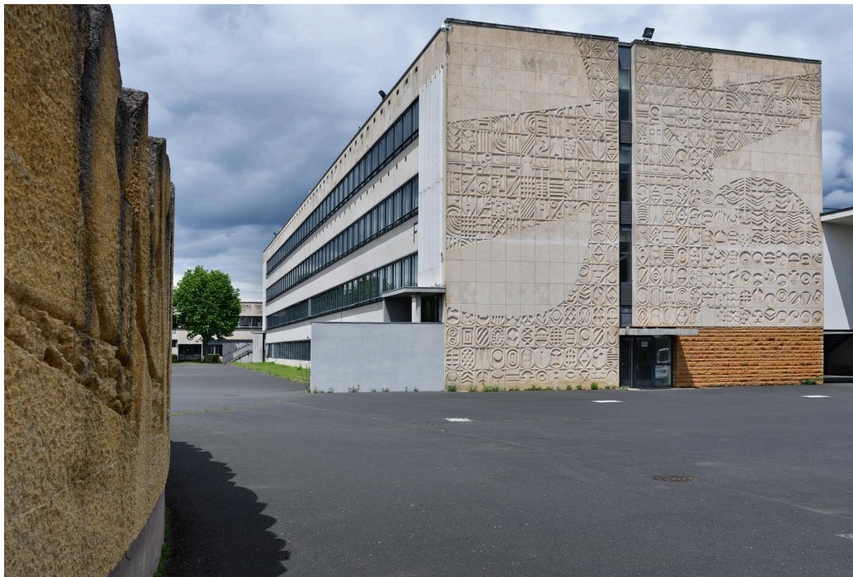
Vue du pignon revêtu.
