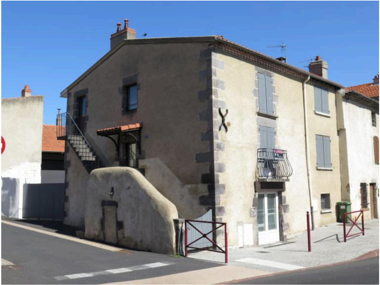
Vue générale des façades principale et latérale
