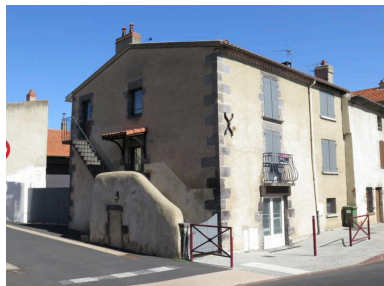
Vue générale des façades principale et latérale Phot. Bruno Decrock IVR84_20206300046NUCA
