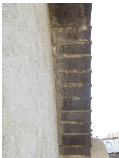
Deuxième partie de l'escalier : vue de dessous Phot. Bruno Decrock IVR84_20206300054NUCA
