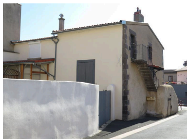
Vue latérale gauche de la maison Phot. Bruno Decrock IVR84_20206300055NUCA
