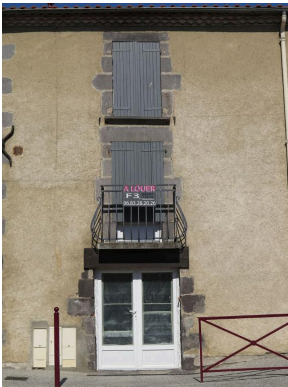
Vue partielle de la façade latérale
