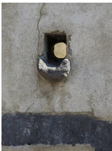
Pierre d'évacuation de l'eau de l'escalier Phot. Bruno Decrock IVR84_20206300056NUCA
