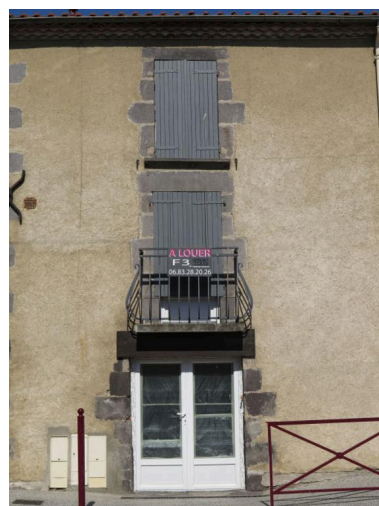
Vue partielle de la façade latérale Phot. Bruno Decrock IVR84_20206300048NUCA
