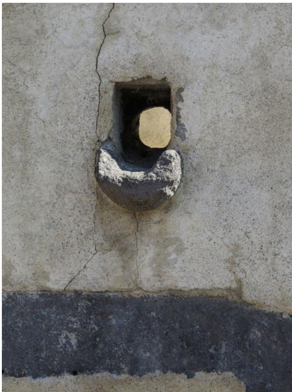
Pierre d'évacuation de l'eau de l'escalier
