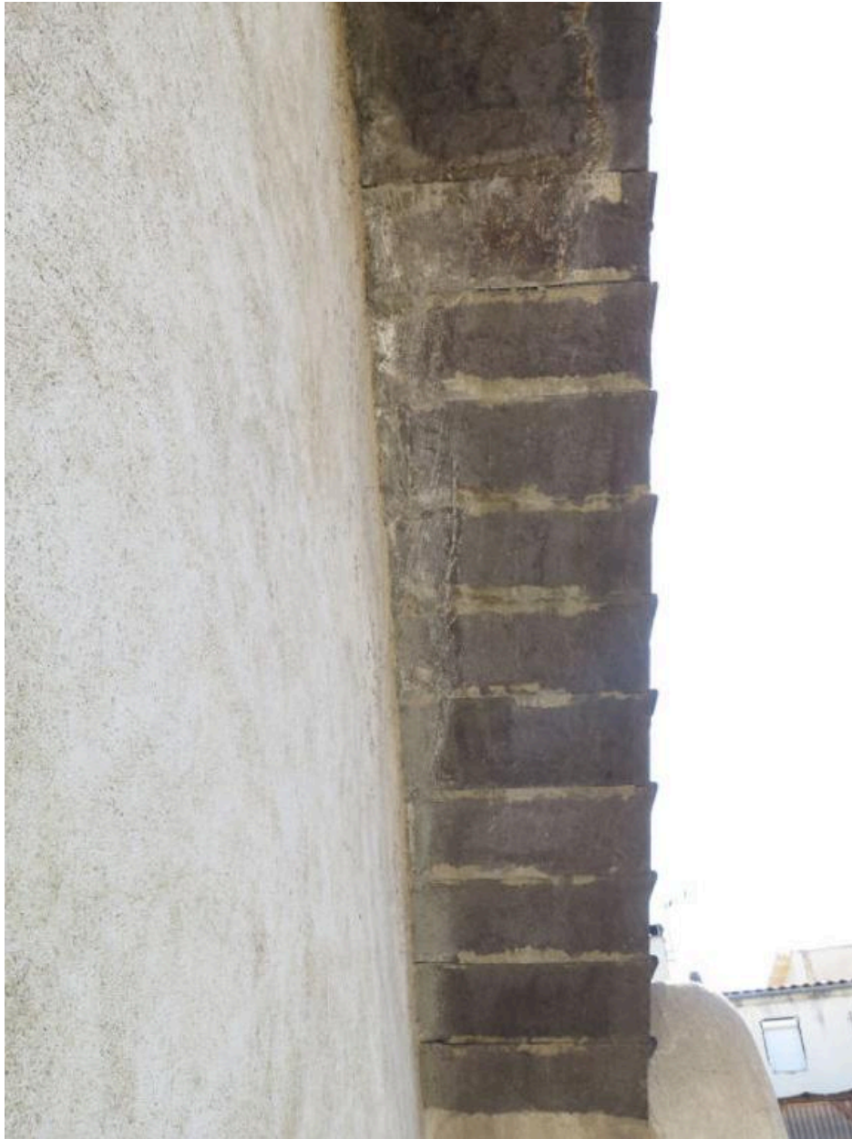
Deuxième partie de l'escalier : vue de dessous
