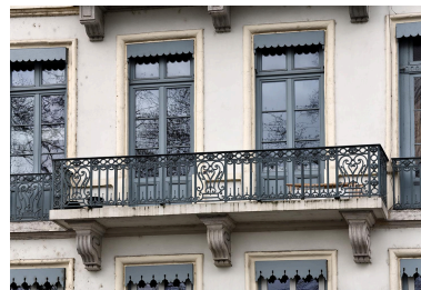
Deuxième étage carré : détail de l'un des balcons Phot. Thierry Leroy IVR84_20246900282NUCAQ
