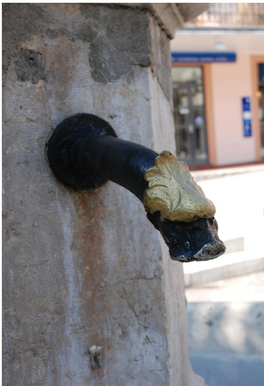
Fontaine, place Charles-Albert. Détail du tuyau.
