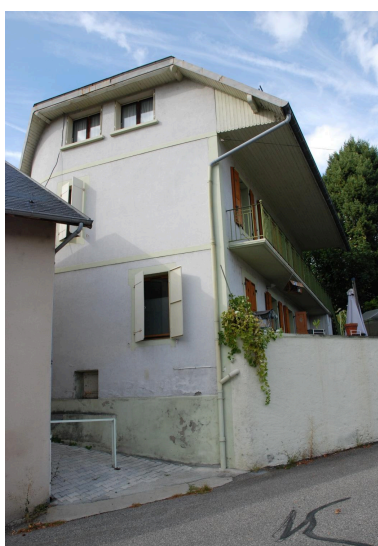
Maison, rue Jean-Louis Bouvet (la Montaz, 2018 E1 849). Au niveau du soubassement, répartiteur du captage dit "Eau des 6e". Phot. Caroline Guibaud IVR84_20257300516NUCA
