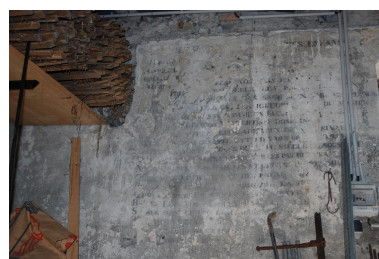
Bâtiment (2018 E1 1834), vestige du couvent des Augustins ? Vue intérieure : inscription. Phot. Caroline Guibaud IVR84_20247301728NUCA
