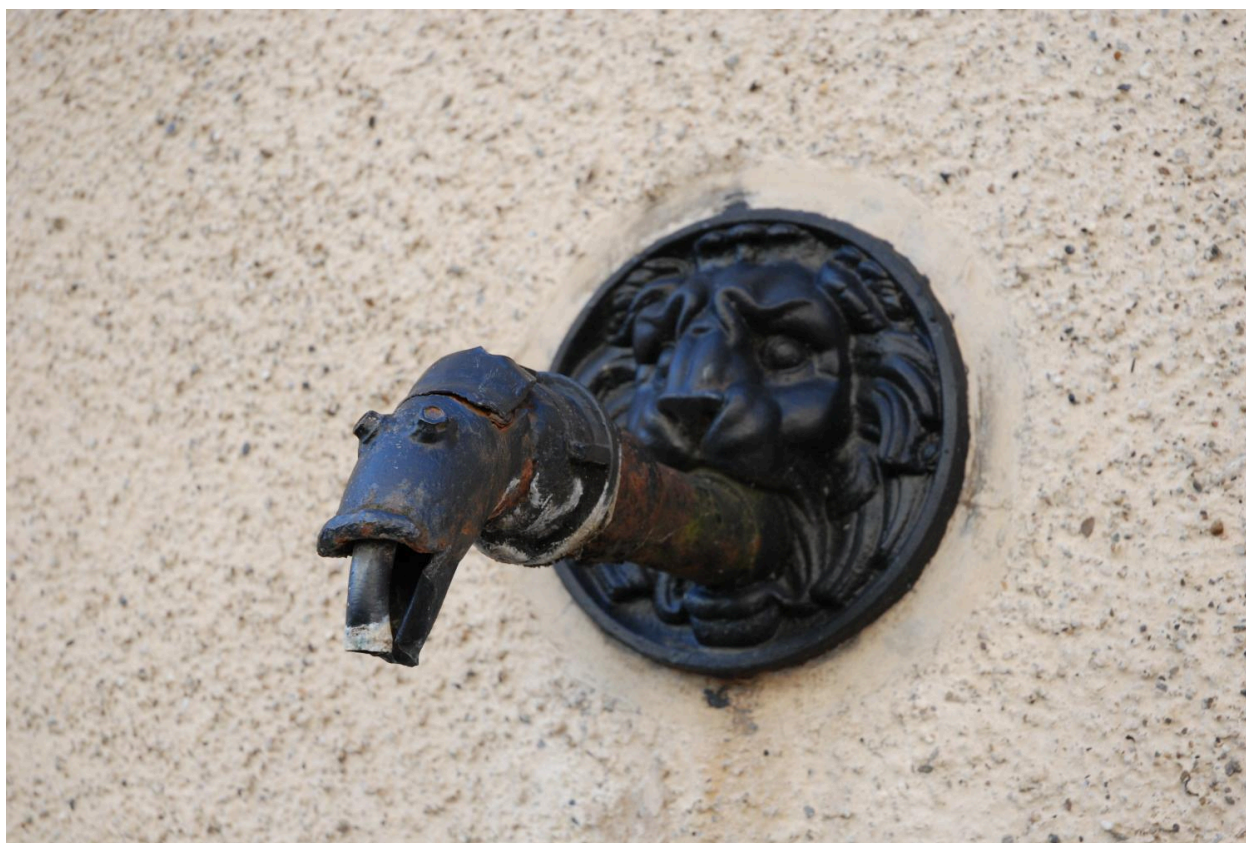
Fontaine, rue Louis Blanc-Pinget (entre les n°35 et 47). Détail du tuyau.
