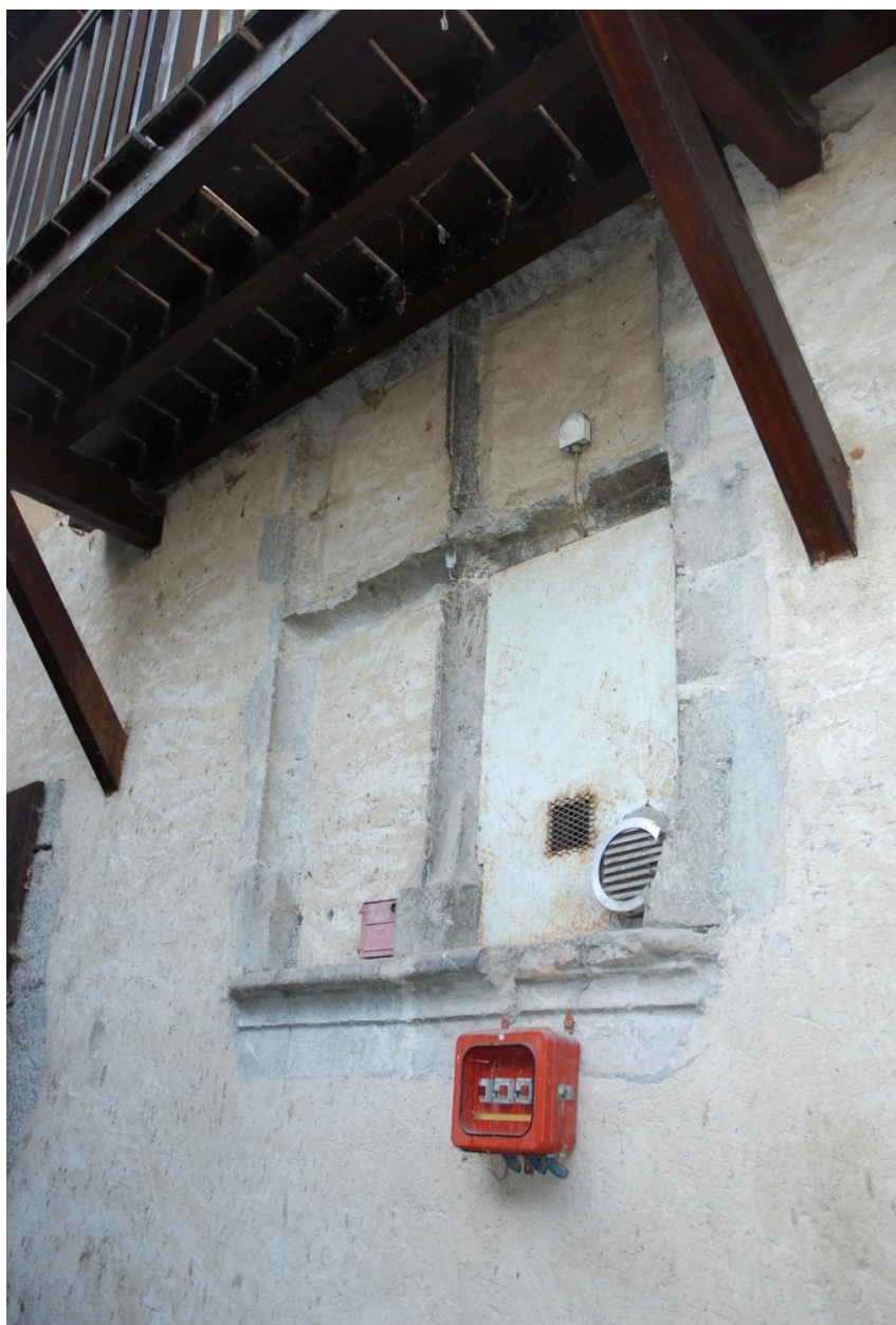
Maison 68 rue Auguste Domenget (2018 E1 1204). Croisée murée au niveau du soubassement côté square de Stetten : vestige du couvent des Augustins ?
