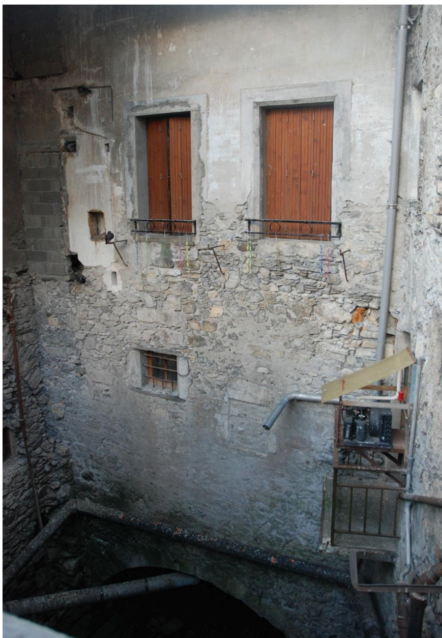
Construction en surplomb au-dessus du Gargot (le bâti n'a pas de numéro cadastral), vue depuis le nord.
