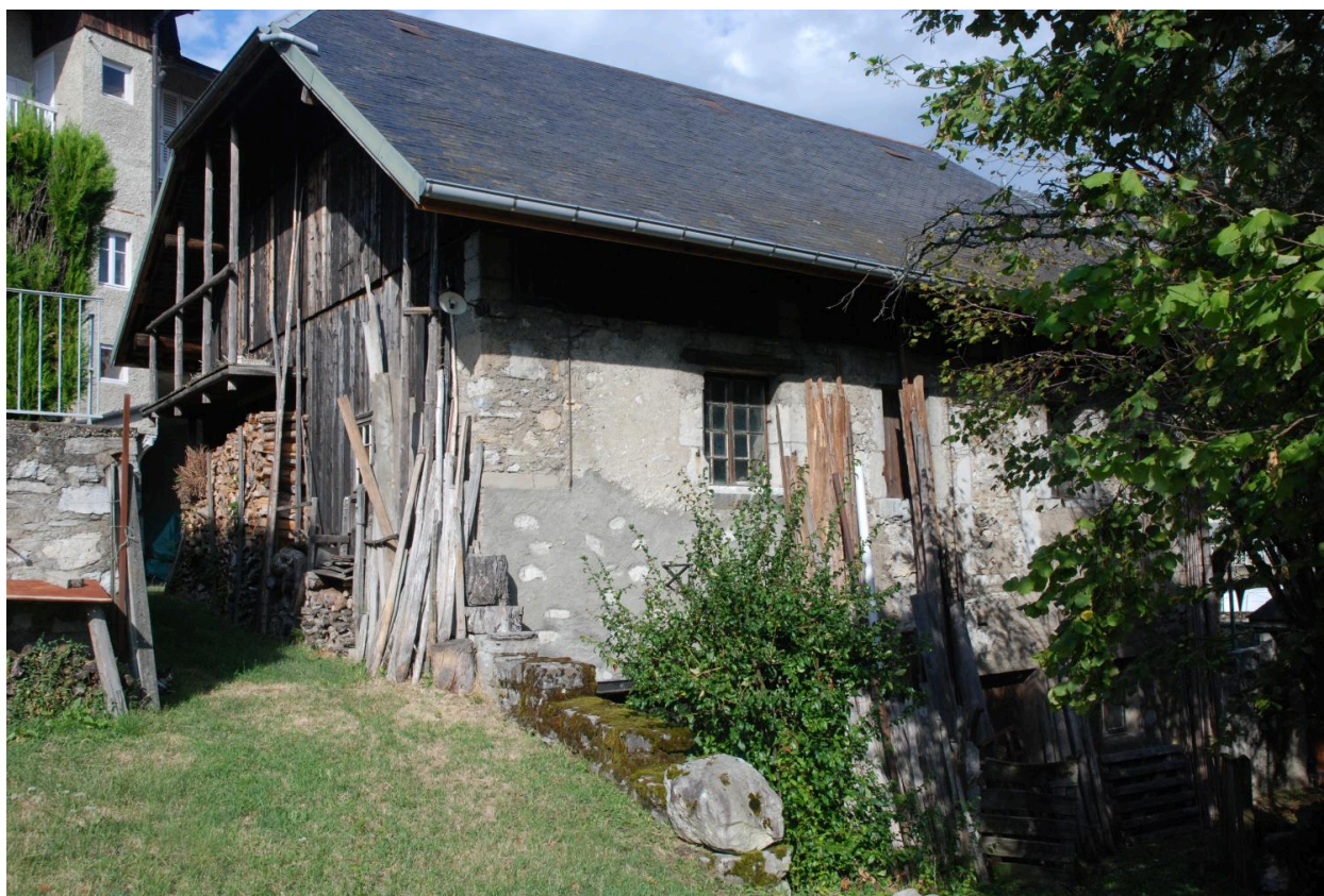
Bâtiment (2018 E1 1834), vestige du couvent des Augustins ?
