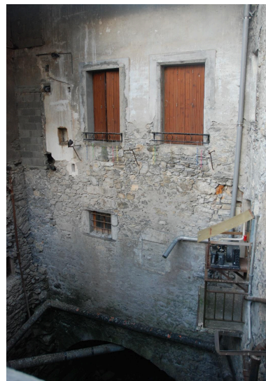
Construction en surplomb au-dessus du Gargot (le bâti n'a pas de numéro cadastral), vue depuis le nord. Phot. Caroline Guibaud IVR84_20257300513NUCA
