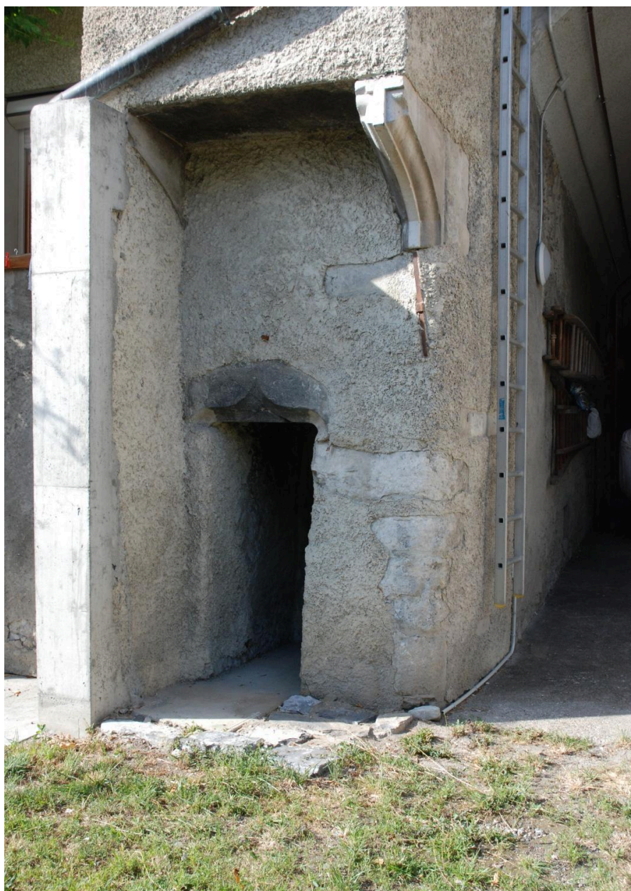
Pierres moulurées en remploi : console de cheminée (vestige du couvent des Augustins ?).
