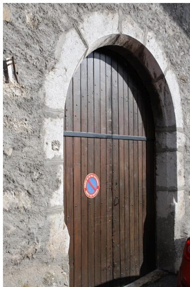
Ferme, dite Clos Pétel, 77 rue Jean-Louis Bouvet (2018 E1 1793). Bâtiment sud, détail de porte. Phot. Caroline Guibaud IVR84_20257300524NUCA
