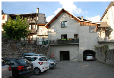
Square de Stetten, vu depuis le sud. la partie orientale (à droite) correspond au cours du Gargot couvert. Phot. Caroline Guibaud IVR84_20257300510NUCA
