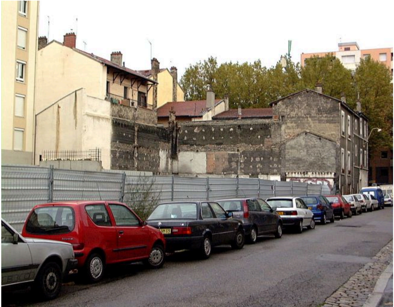
Vue d'ensemble depuis le sud. Les murs en mâchefer.
