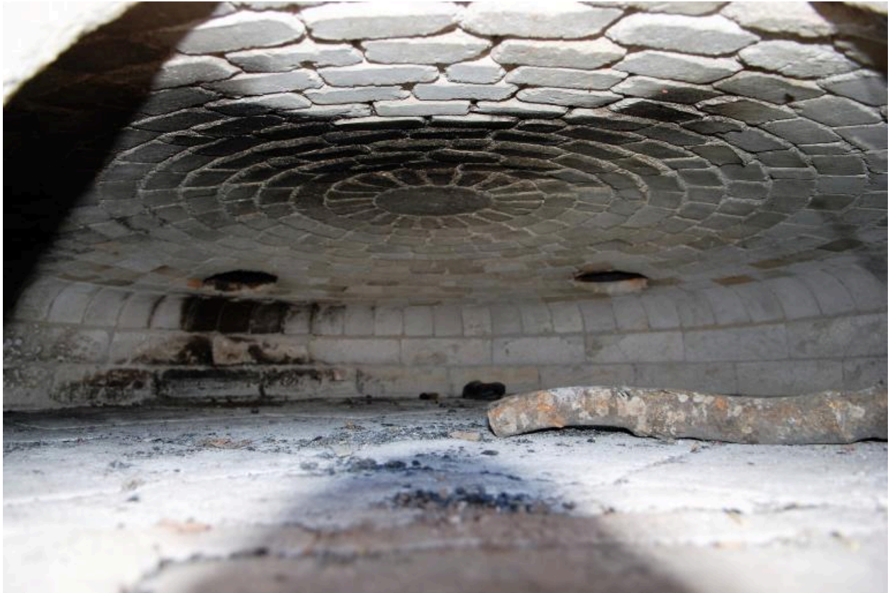
Détail de la voûte du four à pain
