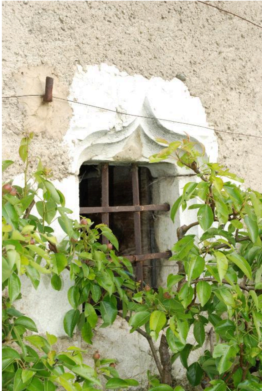
Détail : fenêtre de l'habitation.
