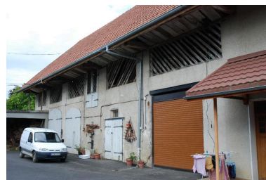
Vue d'ensemble de la grange-étable. Phot. Caroline Guibaud IVR82_20157303092NUCA
