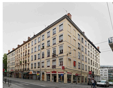
Vue d'ensemble de l'îlot, depuis la rue de Marseille Phot. Eric Dessert IVR84_20166901454NUCA
