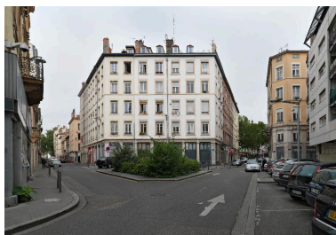
Vue d'ensemble de l'îlot, depuis la place du Commandant-Bulard Phot. Eric Dessert IVR84_20166901453NUCA
