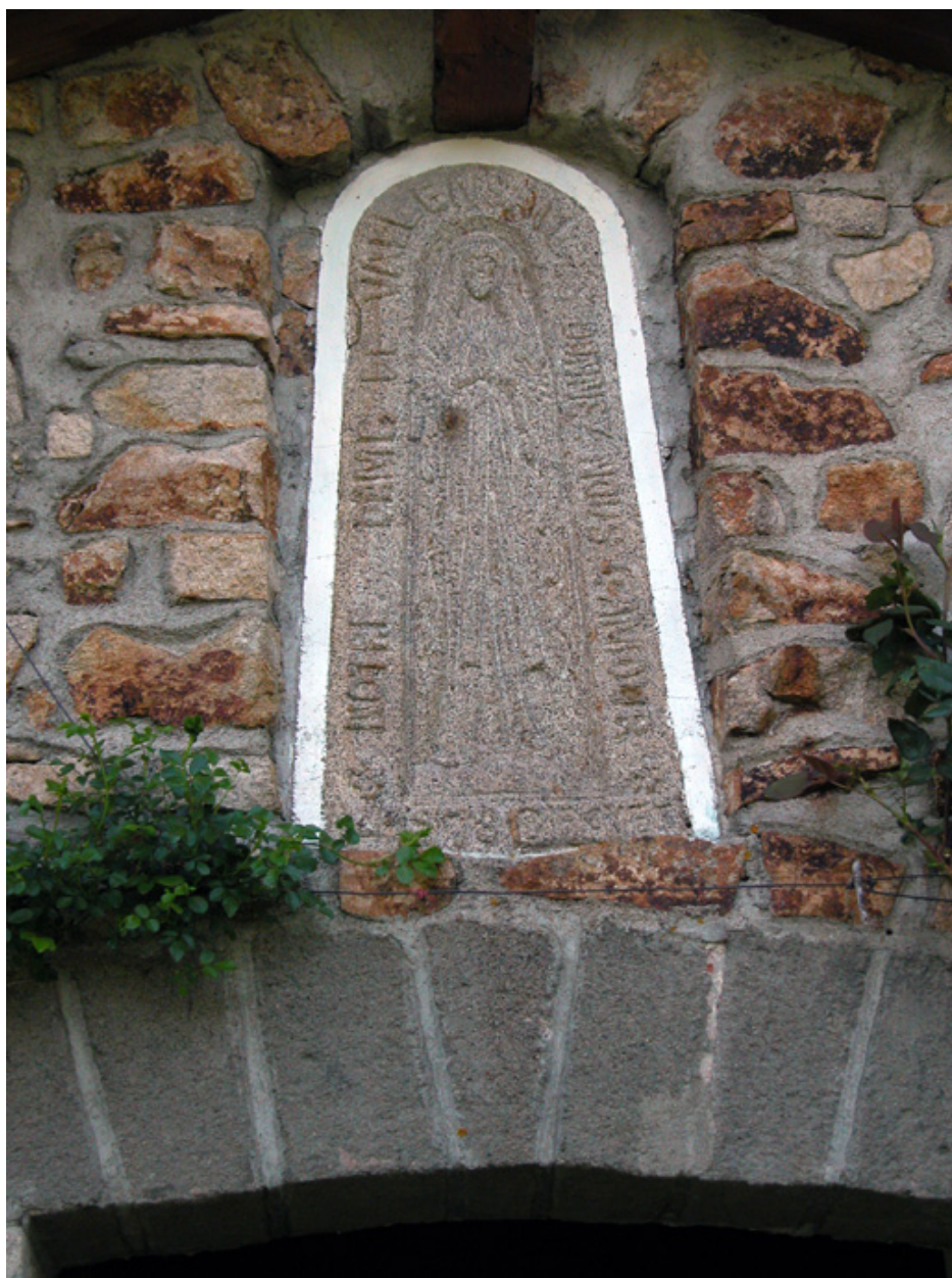
Détail du bas-relief au-dessus de la porte d'entrée de la chapelle.
