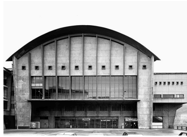
Elévation latérale droite Phot. Jean-Marie Refflé IVR82_19906900033P
