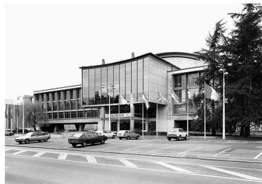
Vue partielle de l'élévation principale Phot. Jean-Marie Refflé IVR82_19906900030P
