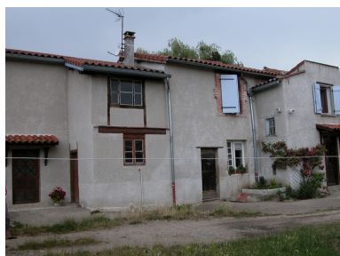
Vue du logis et du logement de la ferme ouest, depuis le sud-est. Phot. Thierry Monnet IVR82_20134200688NUCA
