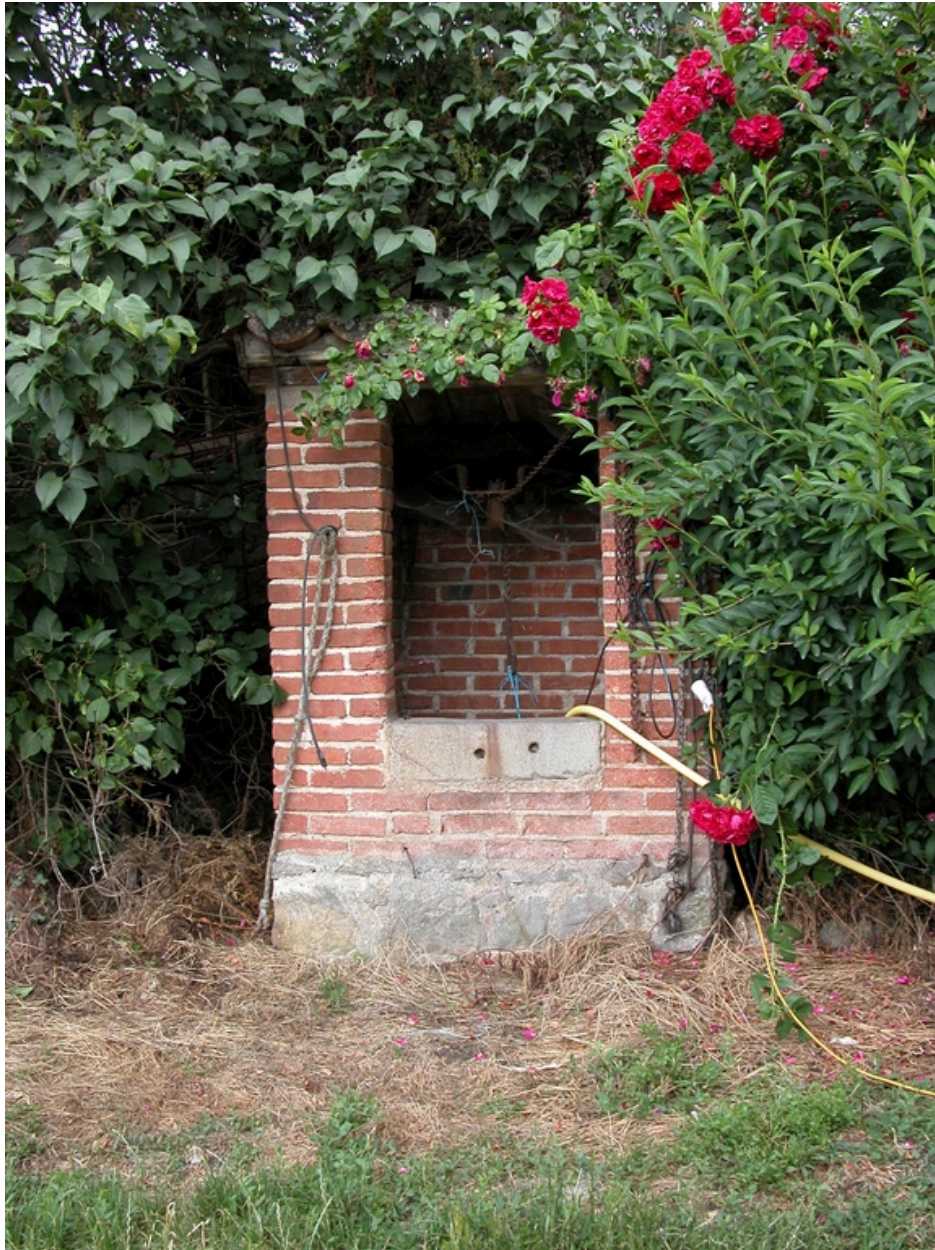
Vue du puits (1999 ZI 55).
