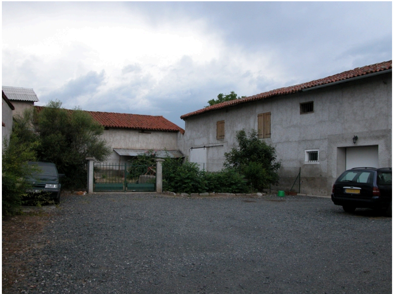
Vue de la grange-étable est et du passage couvert.
