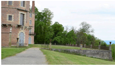
Vue d'ensemble Phot. Maryse Durin-Tercelin IVR84_20226300642NUCA
