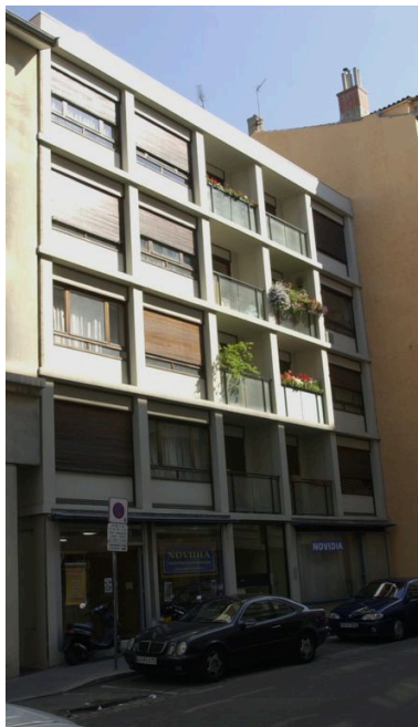
Vue de la façade sur rue Phot. V. Baud IVR82_20046904998NUCA
