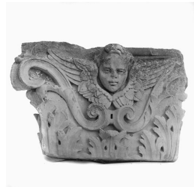
Chapiteau qui proviendrait du couvent d'observants Phot. Bruno Cougnassout IVR82_19826900055X
