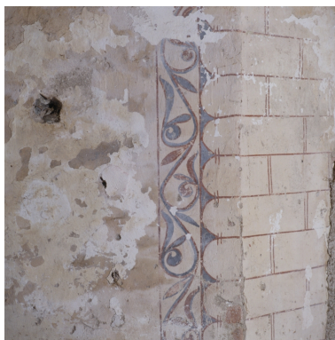
Bas-côté sud, baie de la 2e travée : détail du décor peint. Phot. Jean-Marie Refflé IVR82_20004200532XA
