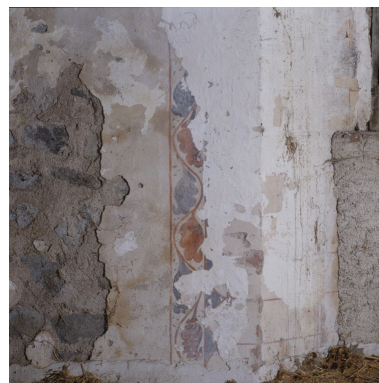
Bas-côté sud, baie de la 3e travée : détail du décor peint. Phot. Jean-Marie Refflé IVR82_20004200534XA
