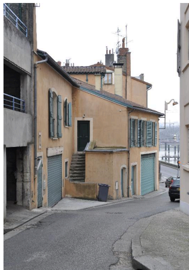
Vue d'ensemble depuis le nord Phot. Catherine Guégan IVR82_20136900328NUCA
