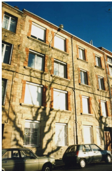
Elévation principale Phot. Cendrine Sanquer IVR82_19974202038ZE
