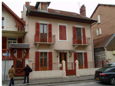
Façade sur rue Phot. François Fouger IVR82_20077300310NUCA
