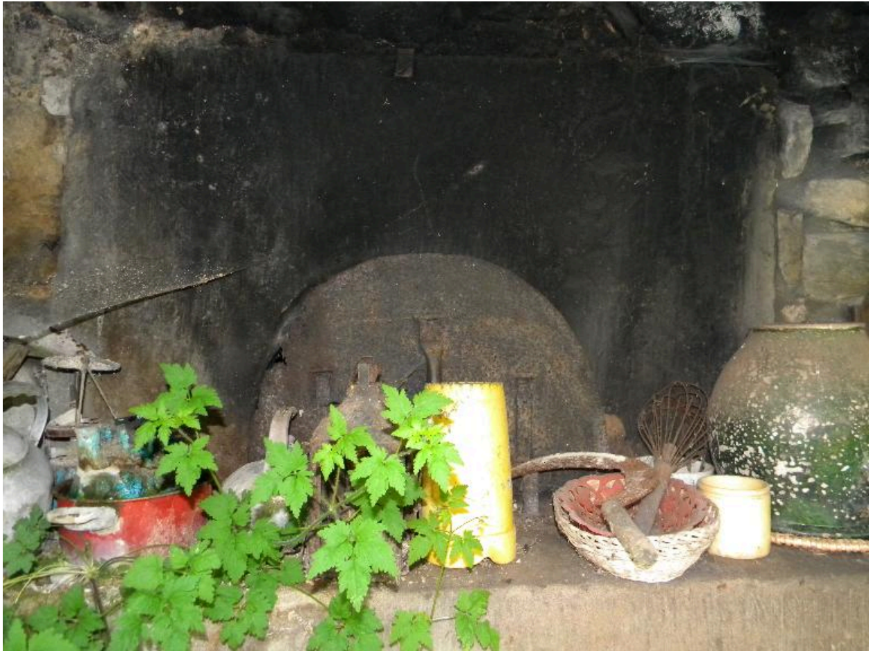
détail de la bouche du four
