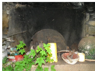
détail de la bouche du four
