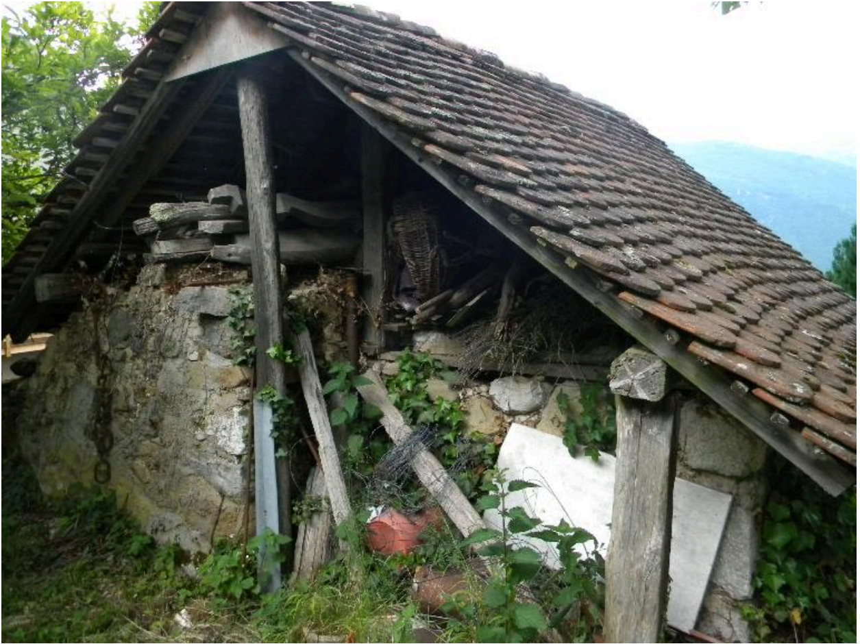
Vue de la façade arrière.
