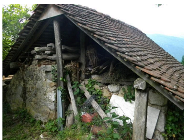
Vue de la façade arrière.
