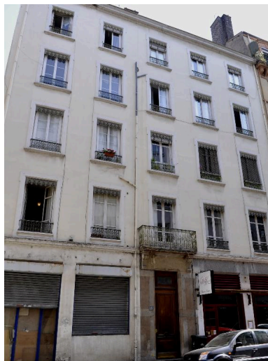
Vue générale de l'élévation sur rue Phot. Magali Delavenne IVR82_20156901227NUCA
