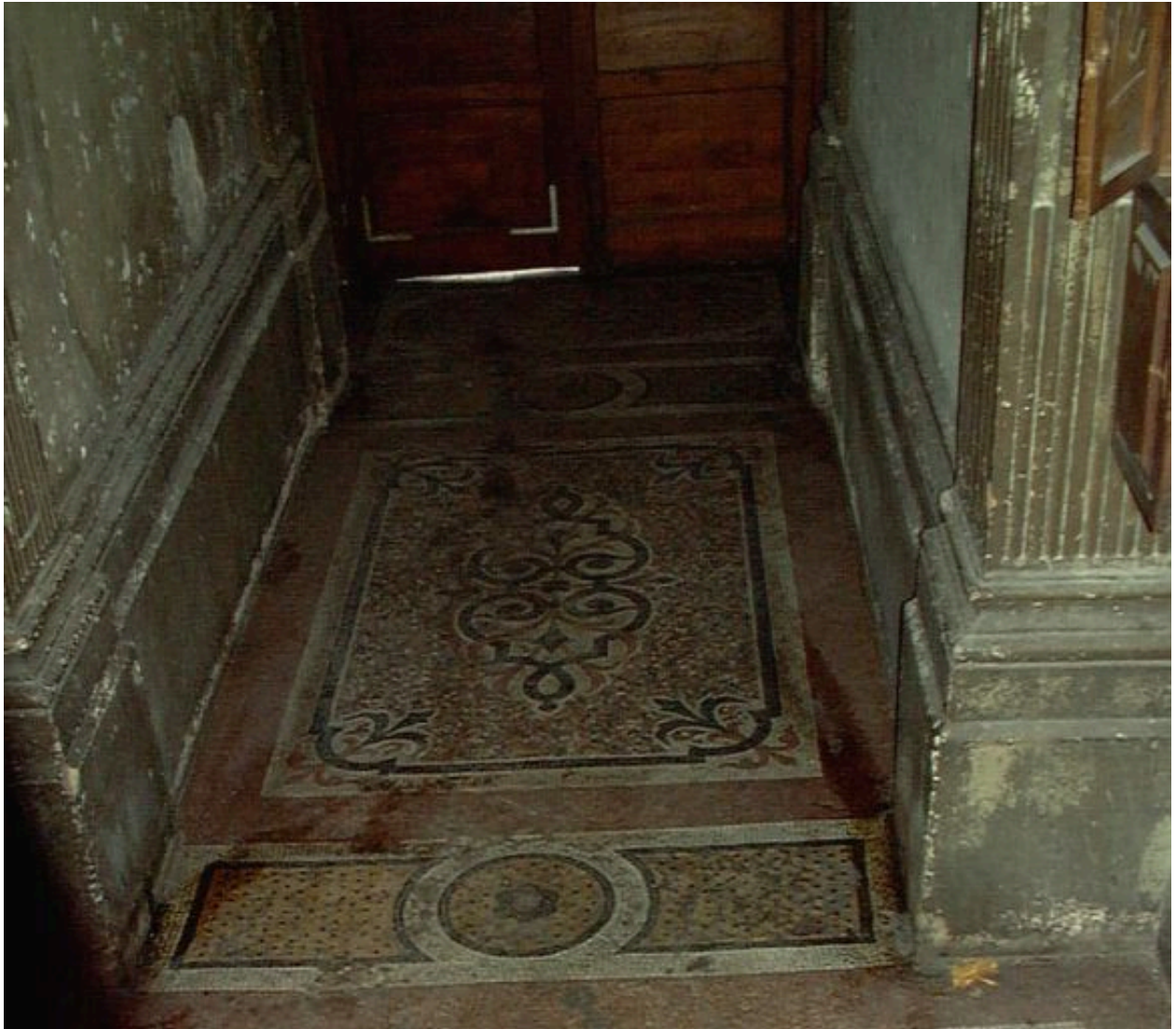
Détail du pavement du vestibule
