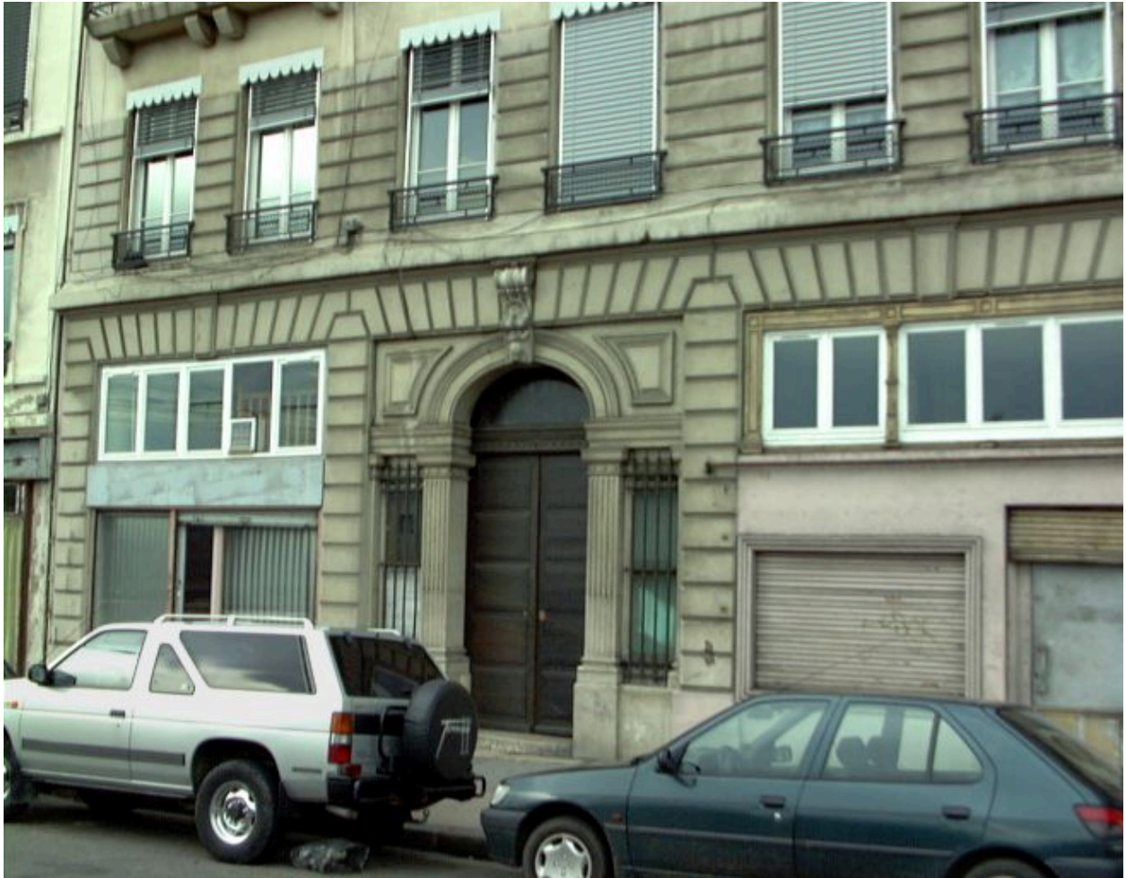
Détail du rez-de-chaussée
