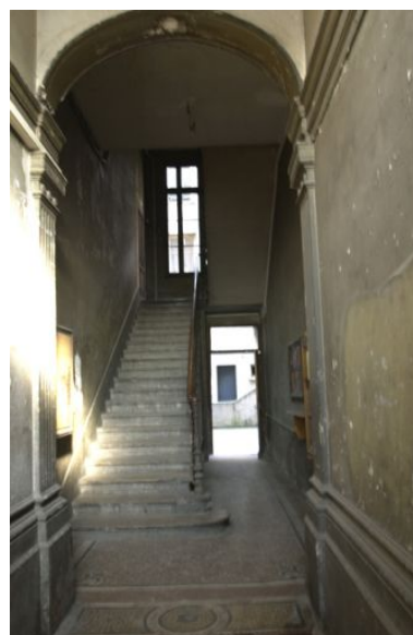
Le vestibule depuis l'entrée Phot. Maryannick Chalabi IVR82_20036900355NUCA
