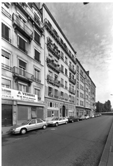
Vue d'ensemble depuis le sud-est Phot. Jean-Marie Refflé IVR82_20016902473V
