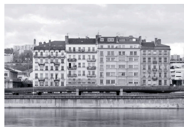
Vue d'ensemble depuis l'est Phot. Eric Dessert IVR82_20026903019X
