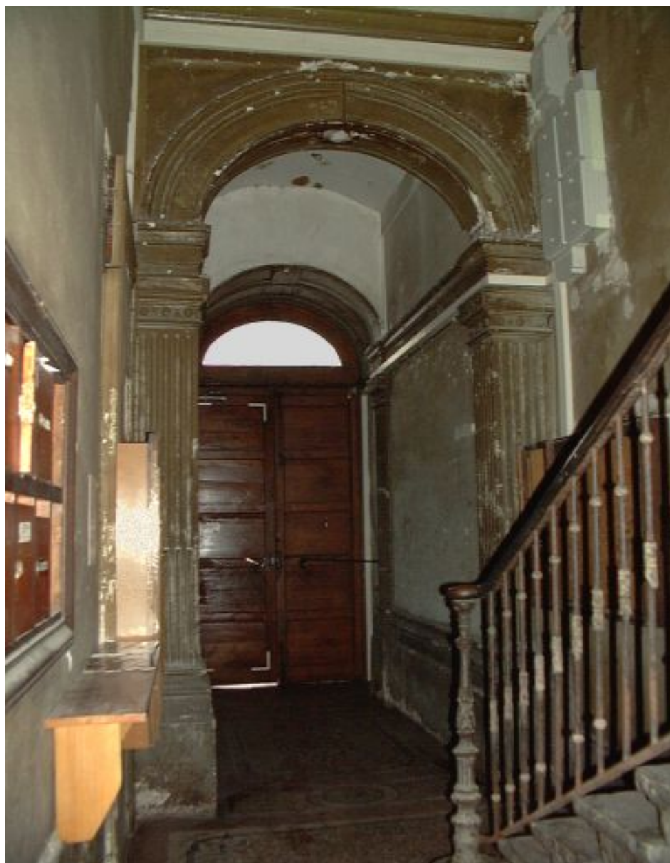
Le vestibule depuis le fond
