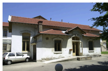
Aile perpendiculaire, façade du petit côté Phot. François Blanchetière IVR82_20016901442NUCA
