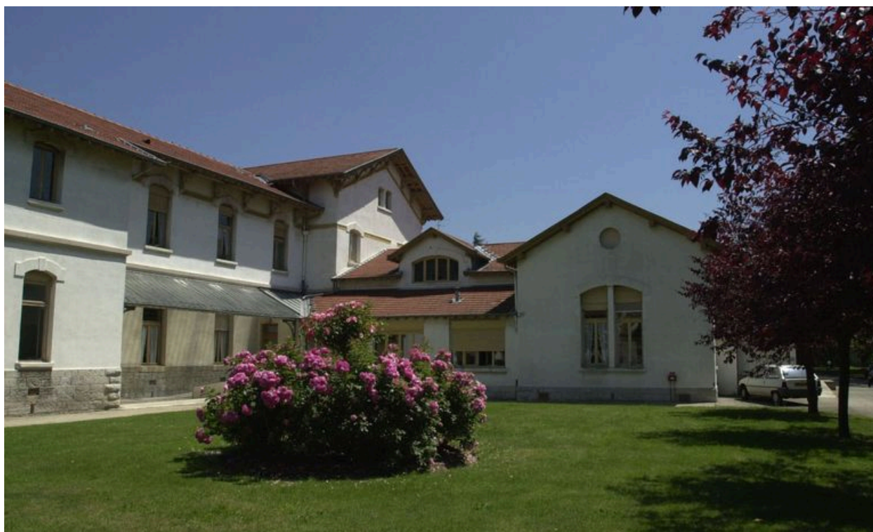
Façade postérieure, partie gauche et aile perpendiculaire
