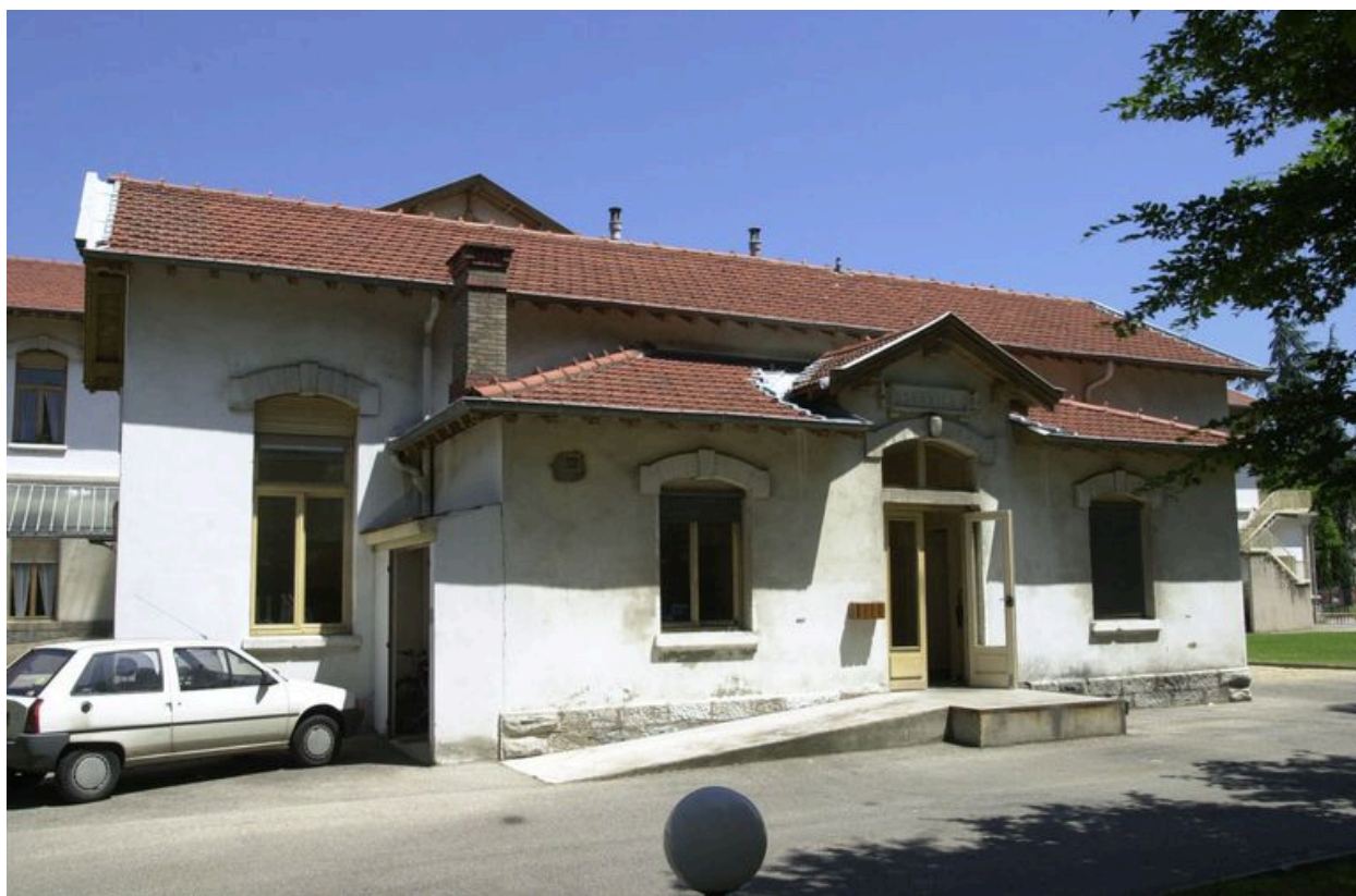
Aile perpendiculaire, façade du petit côté
