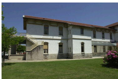
Façade postérieure, partie gauche Phot. François Blanchetière IVR82_20016901438NUCA
