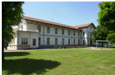
Façade principale, partie gauche Phot. François Blanchetière IVR82_20016901434NUCA
