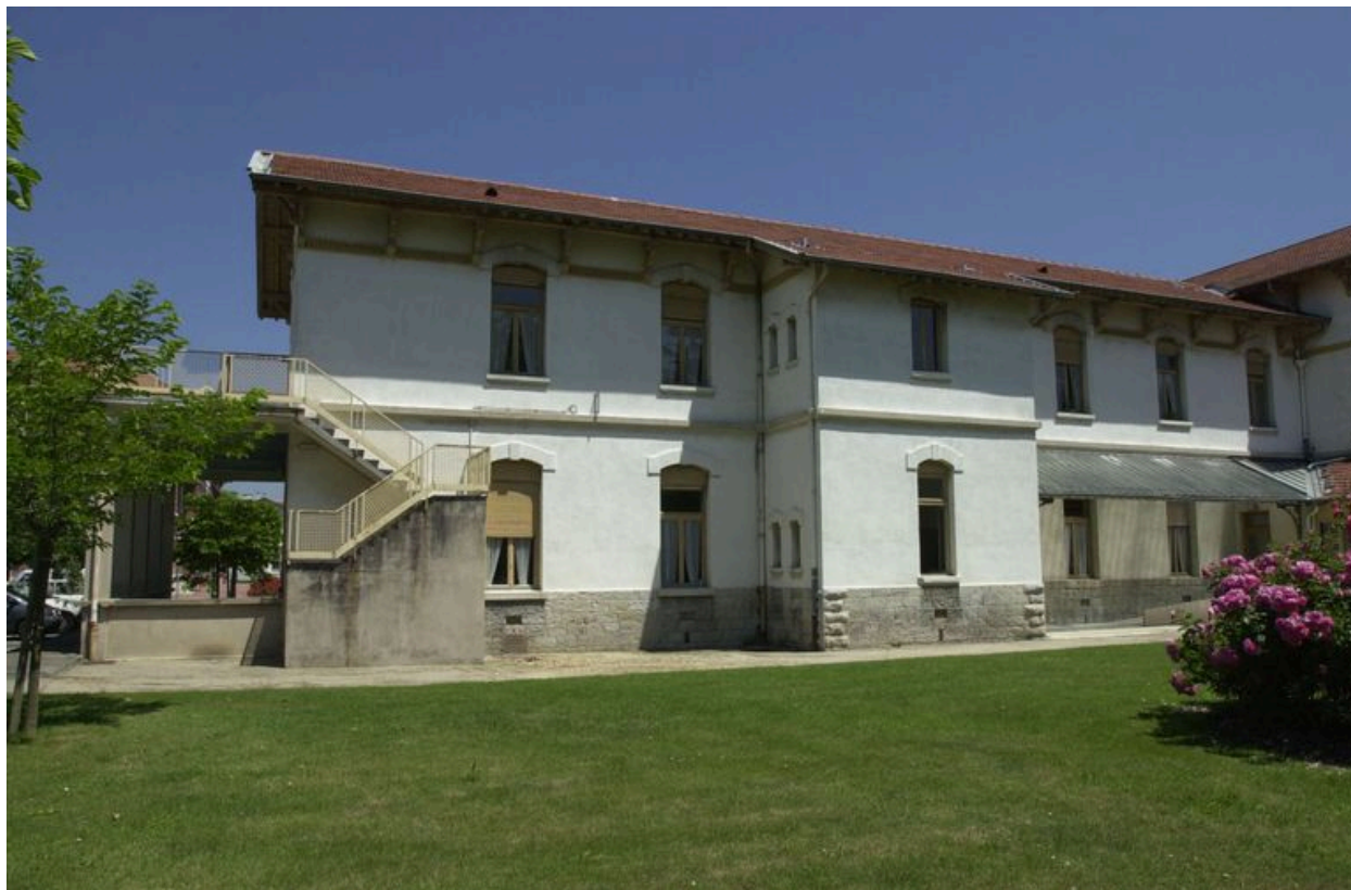
Façade postérieure, partie gauche
