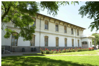
Façade principale, partie droite Phot. François Blanchetière IVR82_20016901435NUCA
