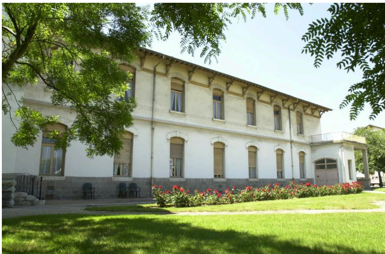
Façade principale, partie droite
