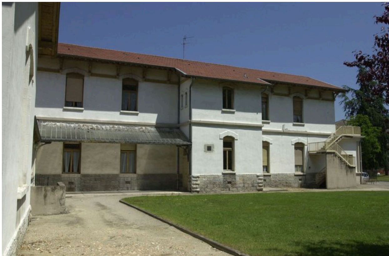
Façade postérieure, partie droite
