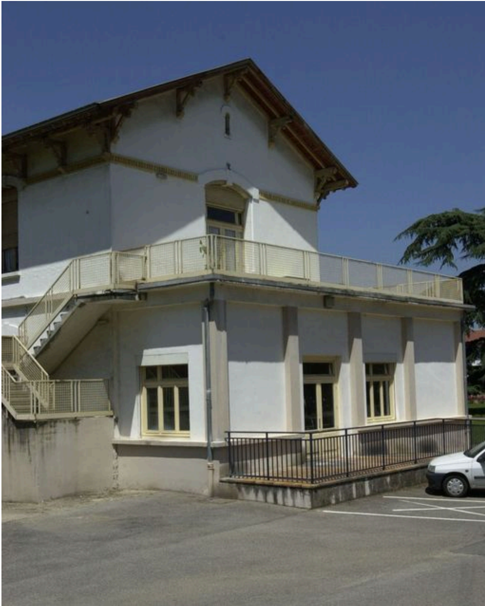
Façade postérieure, extrémité de la partie droite
