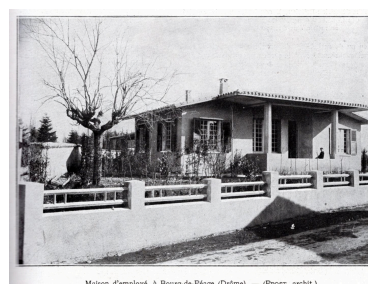
Maison ouvrière de la cité Mossant (Illustration de 1929) (archive privée) Phot. Nadine Halitim-Dubois IVR82_20042600223NUC
