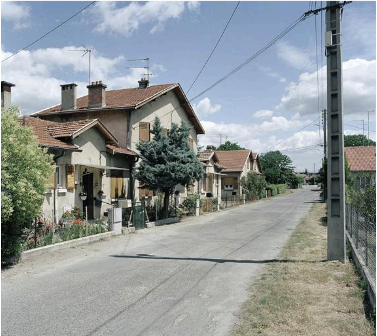
Vue d'ensemble de la cité ouvrière (maison type B ?)
