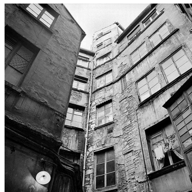
Corps de bâtiment situés au débouché de l'allée Phot. Jean-Marie Refflé IVR82_19826900015X
