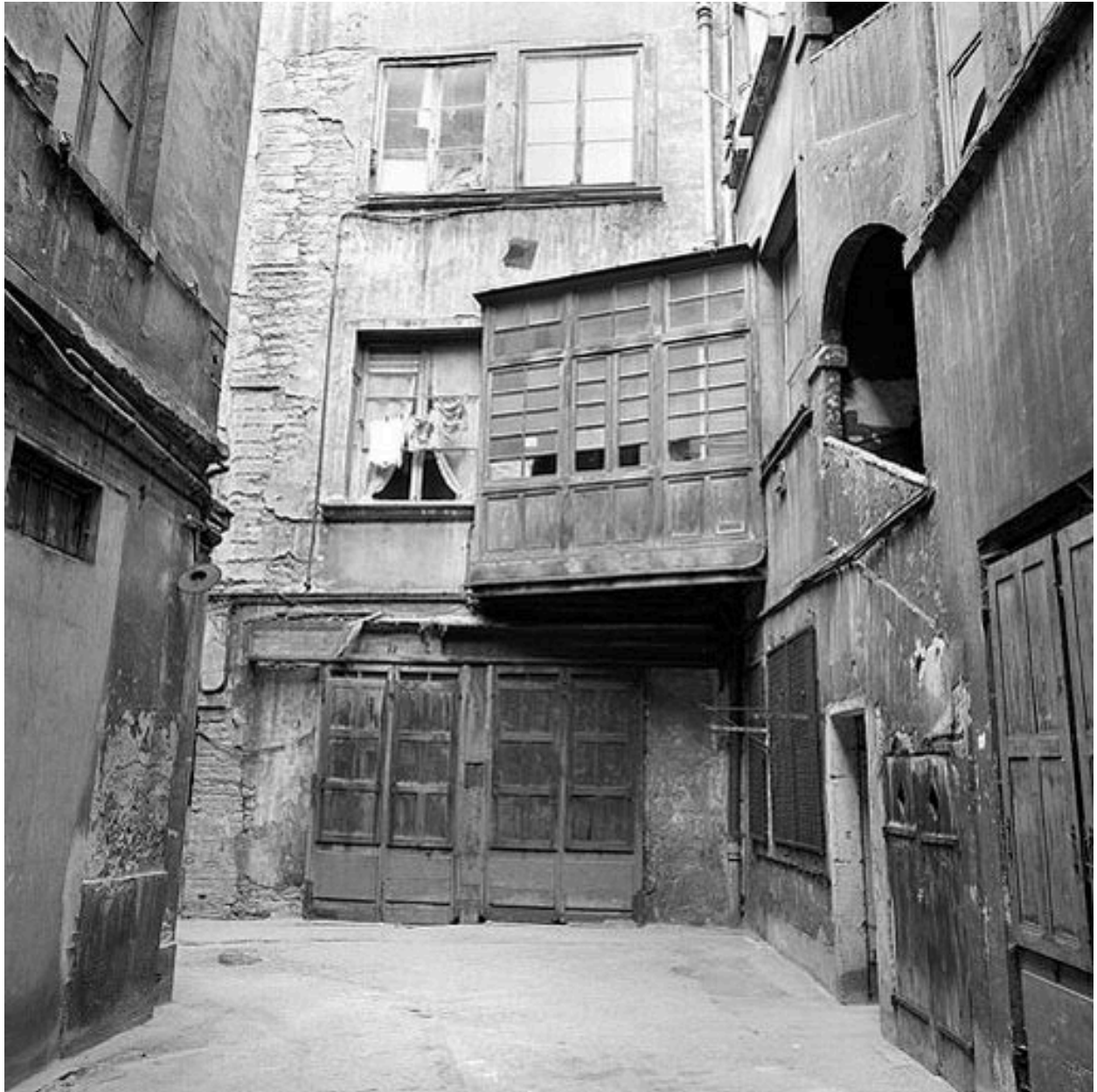
Vue partielle de la cour
