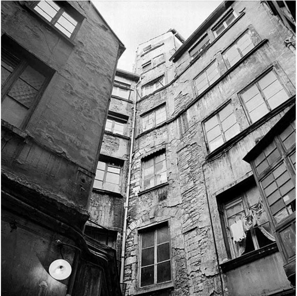
Corps de bâtiment situés au débouché de l'allée
