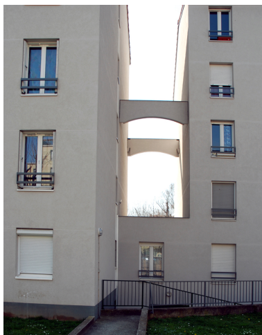
Vue de la liaison entre les deux immeubles Phot. Catherine Guégan IVR82_20126902473NUCA
