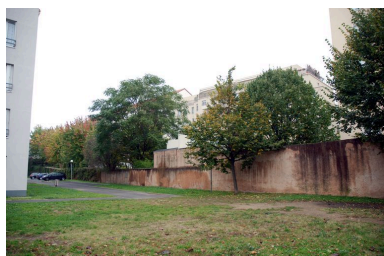
Vue nord de la parcelle, mur de clôture Phot. Maryannick Chalabi IVR82_20116901561NUCA
