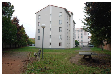
Vue de l'élévation depuis le sud est Phot. Maryannick Chalabi IVR82_20116901559NUCA
