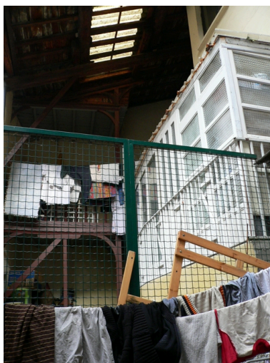
Façade arrière Phot. Isabelle Dupuis IVR82_20093800306NUCA
