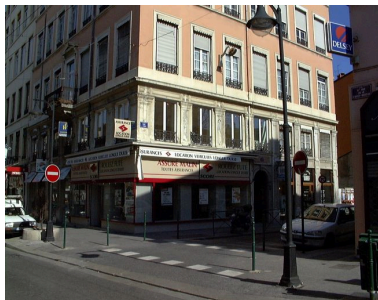
Détail de l'entresol Phot. Véronique Belle IVR82_20006900149NUCA
