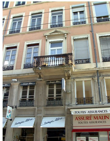
Détail d'élévation, Grande rue de la Croix-Rousse Phot. Véronique Belle IVR82_20006900150NUCA
