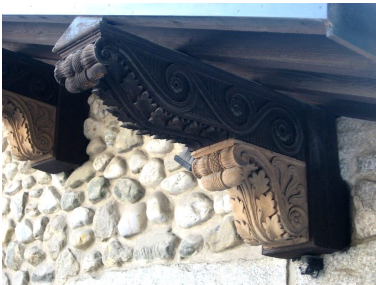
Détail d'une console supportant l'avant-toit
