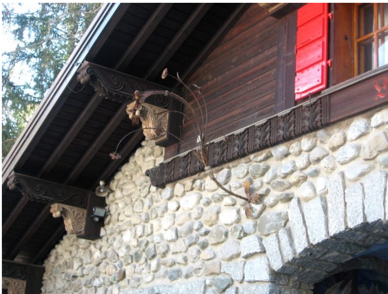
Les consoles supportant l'avant-toit
