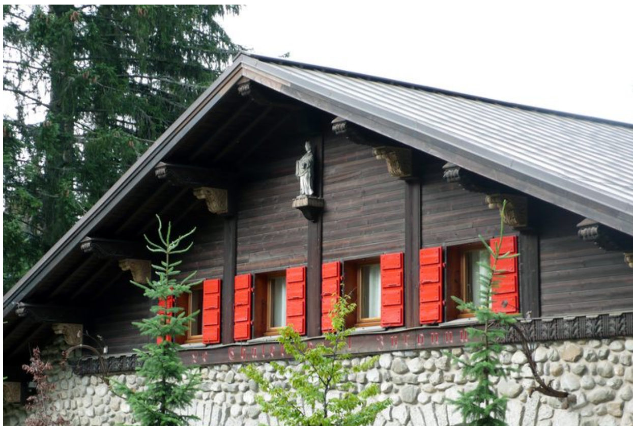
Vue du pignon est
