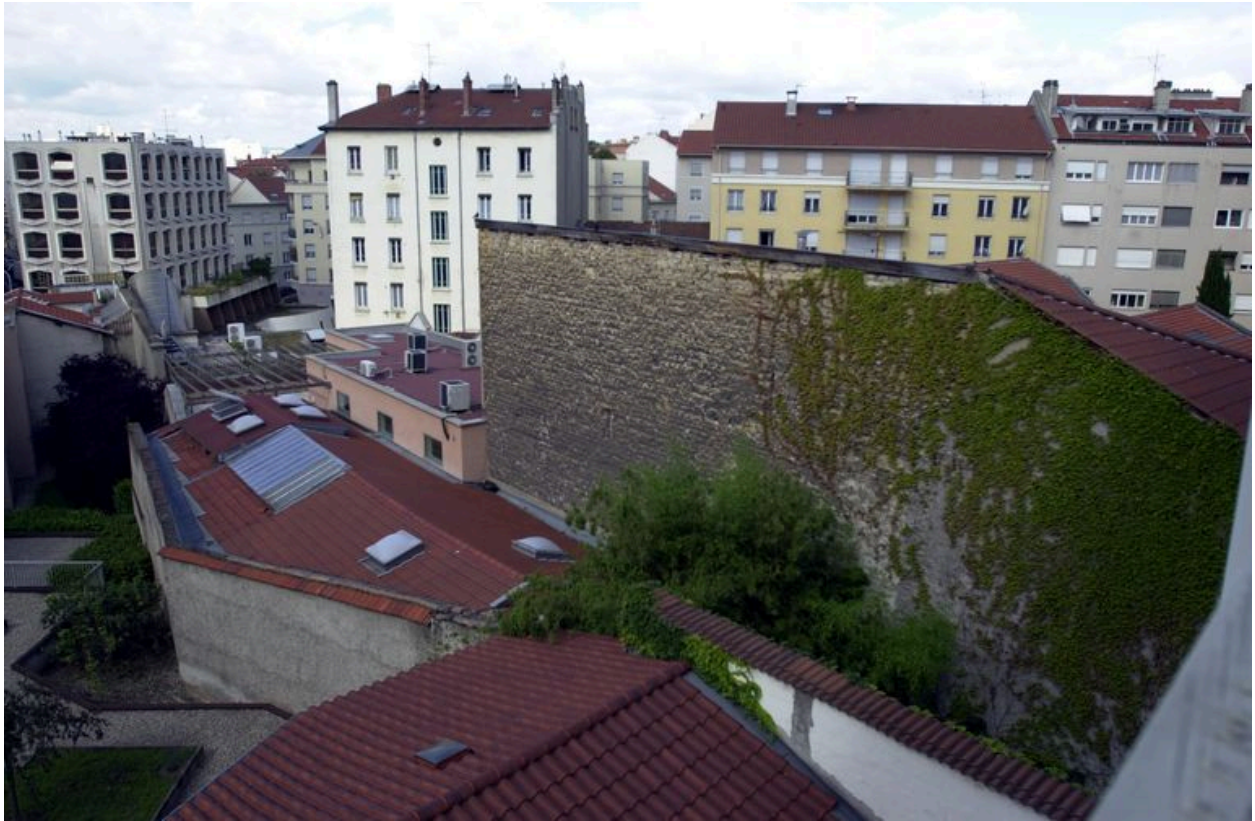
Vue de l'ancien atelier sur cour, aménagé en garage
