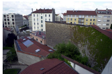
Vue de l'ancien atelier sur cour, aménagé en garage Phot. Maryannick Chalabi IVR82_20076902041NUCA
