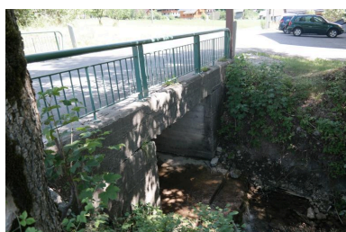
Ponceau de la Pesse, face aval Phot. Pascale Renard IVR84_20207400910NUCA
