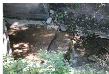
Ponceau de la Pesse, le seuil Phot. Pascale Renard IVR84_20207400912NUCA
