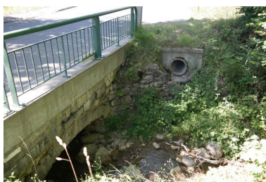
Ponceau de la Pesse, détail de la rambarde et d'une arrivée d'eau Phot. Pascale Renard IVR84_20207400913NUCA
