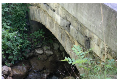
Ponceau de la Pesse, détail de la voûte Phot. Pascale Renard IVR84_20207400911NUCA
