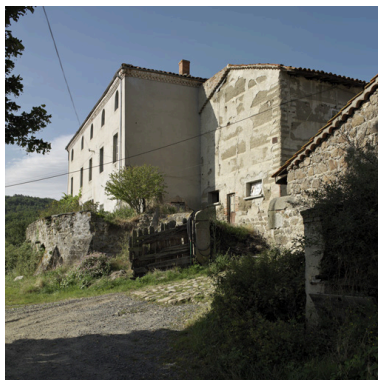
Vue depuis le nord-est (articulation avec la demeure). Phot. Eric Dessert IVR82_20064202098NUCA
