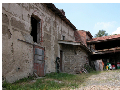
Vue de l'étable, du logis du fermier (édicule en moellon de granite en saillie : évier) et remise ouverte en retour, depuis le nord-est. Phot. Thierry Monnet IVR82_20134200861NUCA
