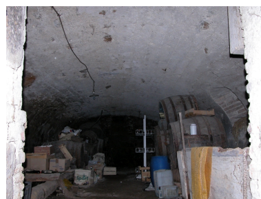
Vue intérieure de la cave. Phot. Thierry Monnet IVR82_20134200859NUCA
