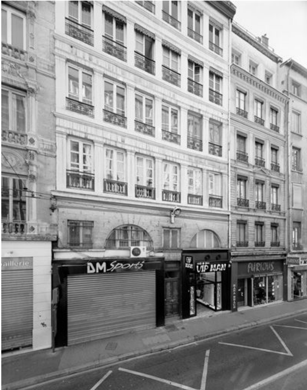
Vue générale de la façade
