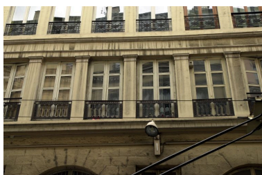
Façade, détail des fenêtres du 1er étage carré Phot. Bernard Ducouret IVR82_20036901191NUCA
