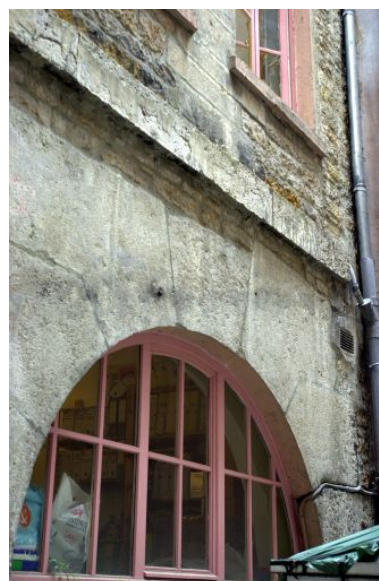
Aile gauche sur la cour, détail d'une fenêtre de l'entresol Phot. Bernard Ducouret IVR82_20036901194NUCA
