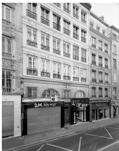
Vue générale de la façade Phot. Didier Gourbin IVR82_20056902663V
