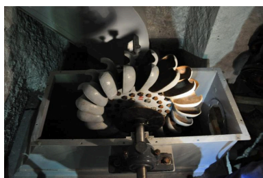
La turbine à augets. IVR84_20177300898NUCA
