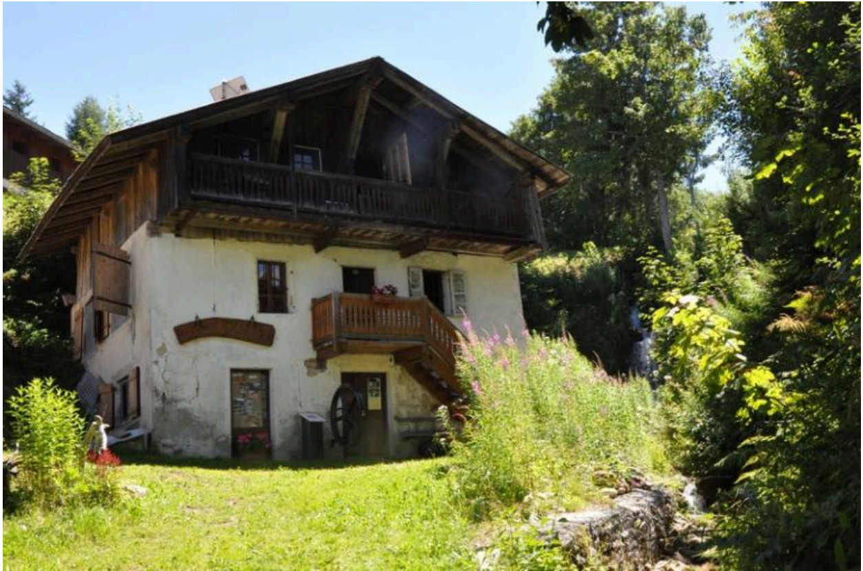
Pignon ouest du moulin.
