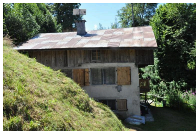
Façade nord du moulin. IVR84_20177300911NUCA
