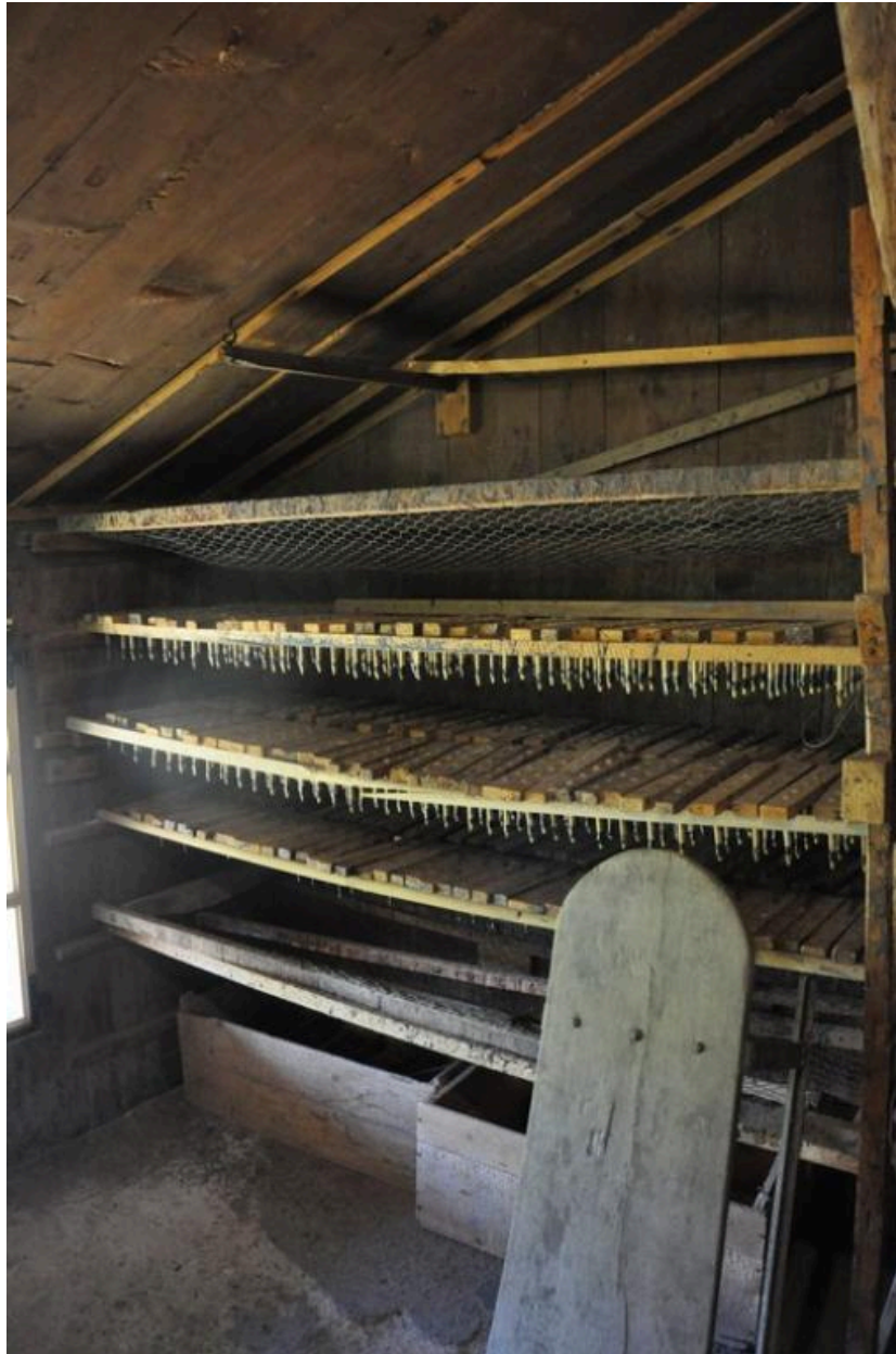
Espace de séchage des manches.
