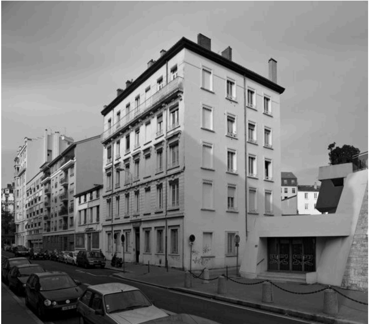
Vue générale depuis le sud-ouest
