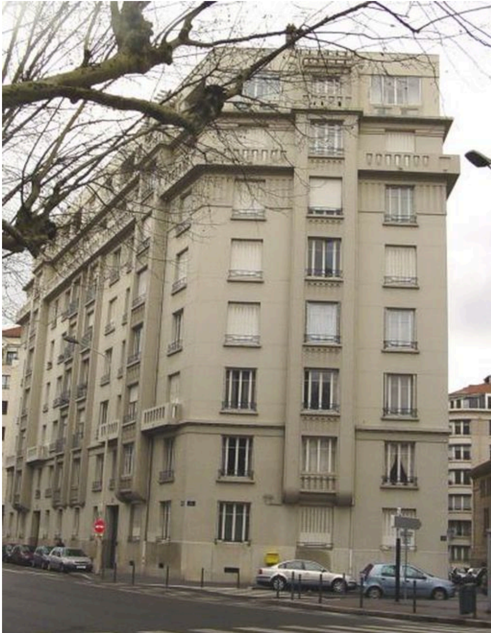
Vue de l'élévation depuis le nord-ouest
