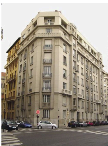
Vue de l'élévation depuis le sud-est Phot. Anaïs Beccaria IVR82_20046903323NUCA
