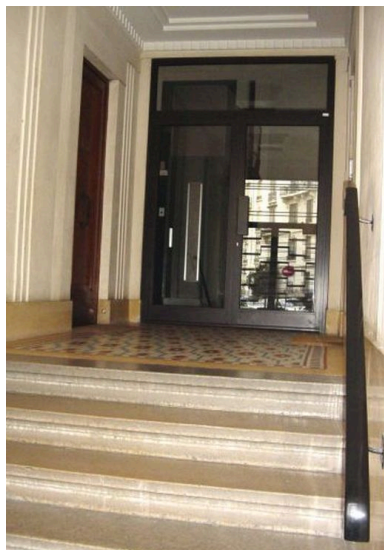
Vestibule-sas 74, boulevard des Belges Phot. Anaïs Beccaria IVR82_20046903328NUCA
