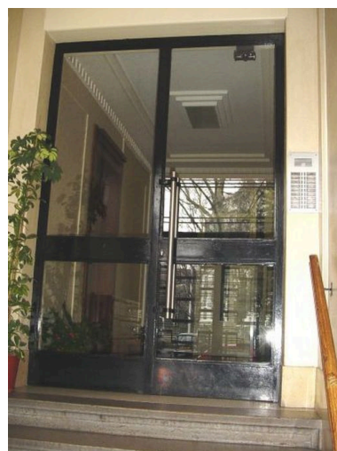
Vestibule-sas 76, boulevard des Belges Phot. Anaïs Beccaria IVR82_20046903333NUCA
