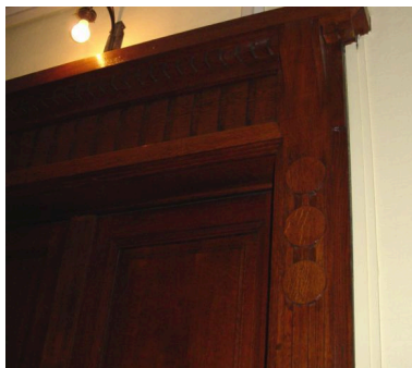
Détails des huisseries d'une porte palière Phot. Anaïs Beccaria IVR82_20046903335NUCA
