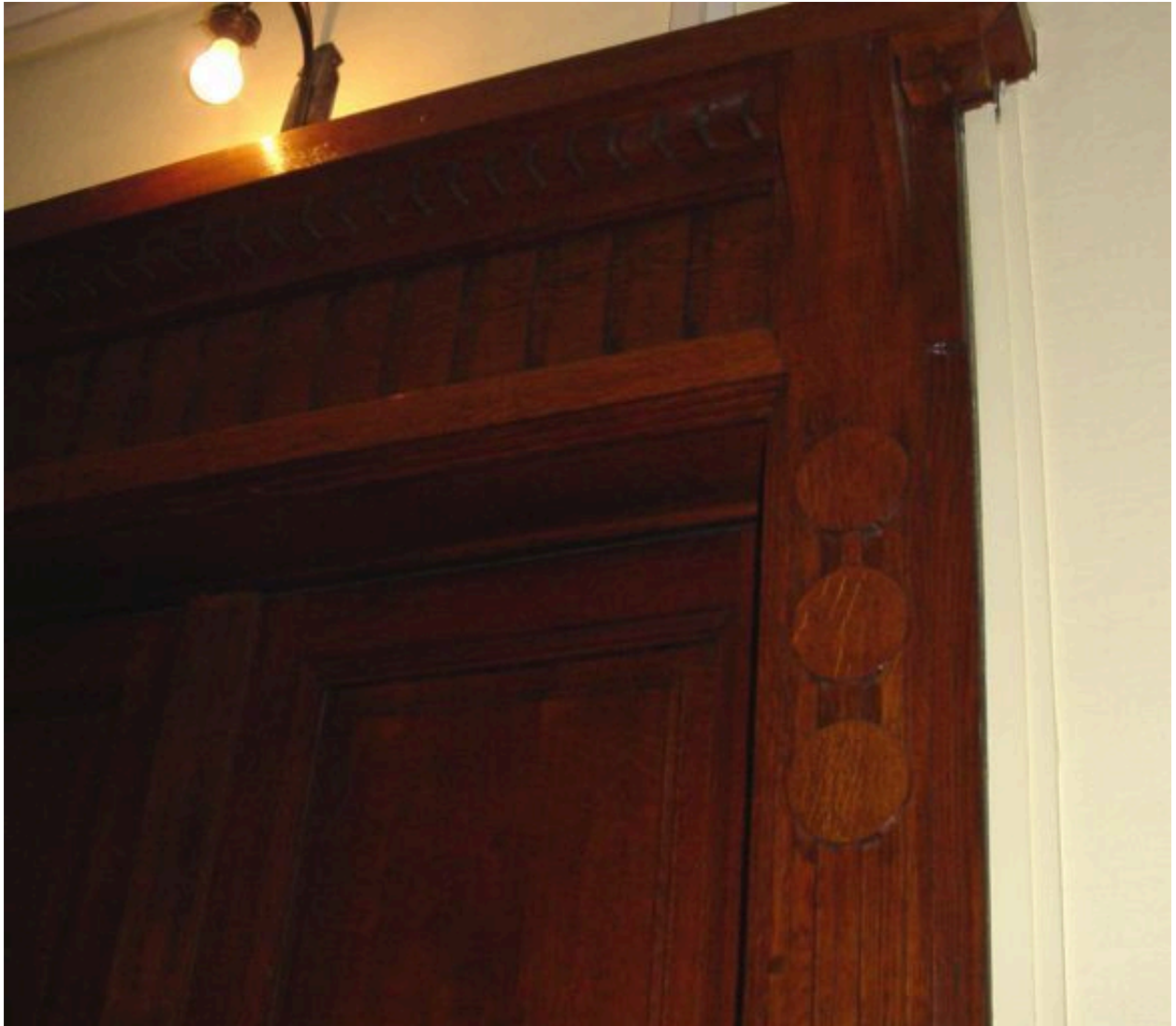
Détails des huisseries d'une porte palière
