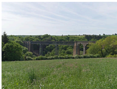
La voie ferrée au passage du viaduc du Belon. Les 7 viaducs de cette petite ligne d'à peine 70 km ne semblent pas tous avoir marqué les rédacteurs de guides. C'est le cas de ce viaduc du Belon, qui n'est jamais mentionné. Tout au plus les guides notent-ils le passage du chemin de fer sur un "plateau très raviné et assez laid" (guide Joanne 1901) et le franchissement du ruisseau du Belon, sans précision.
