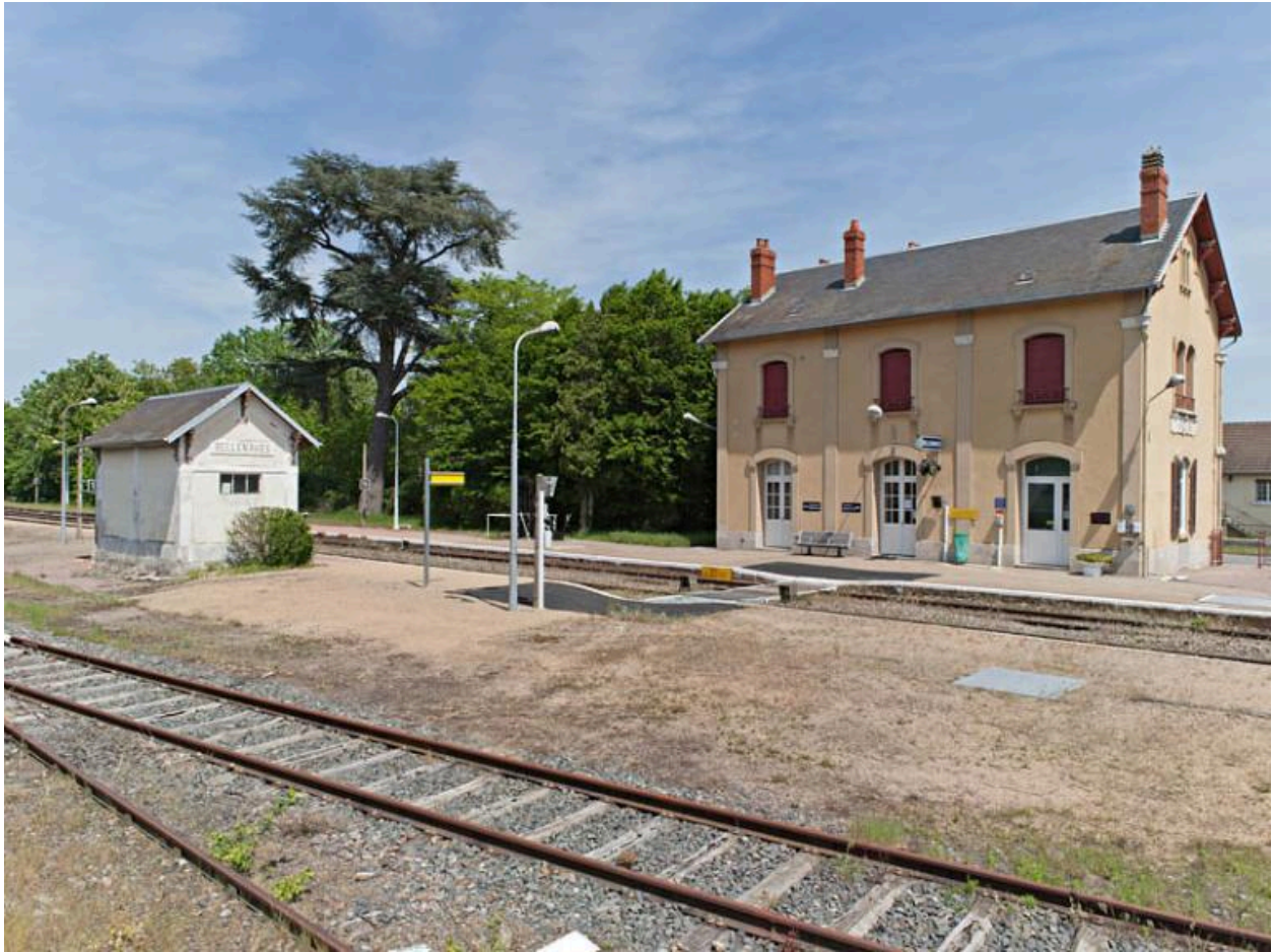
La gare de Bellenaves et l'abri des voyageurs (au lieu-dit la Charrière), côté voies.
