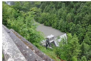
Le barrage des Mottets vu depuis la route départementale. IVR84_20177300871NUCA
