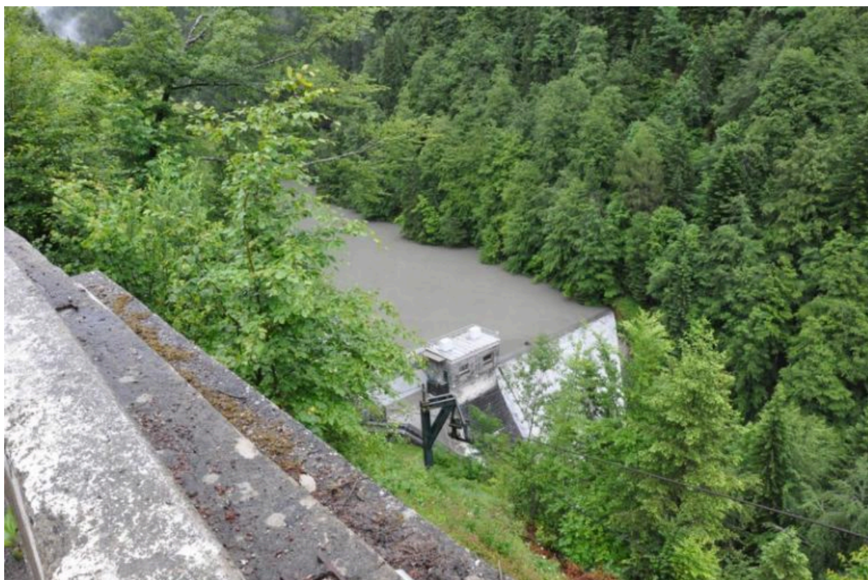
Le barrage des Mottets vu depuis la route départementale.
