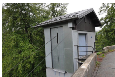
Bâtiment situé au bord de la route départementale. Il est relié au barrage des Mottets par un câble qui permet de descendre du matériel. IVR84_20177300872NUCA
