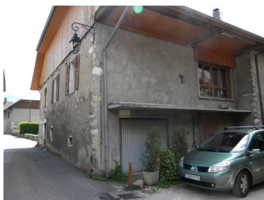
Vue de la façade arrière. Phot. Jérôme Daviet IVR82_20117400619NUCA
