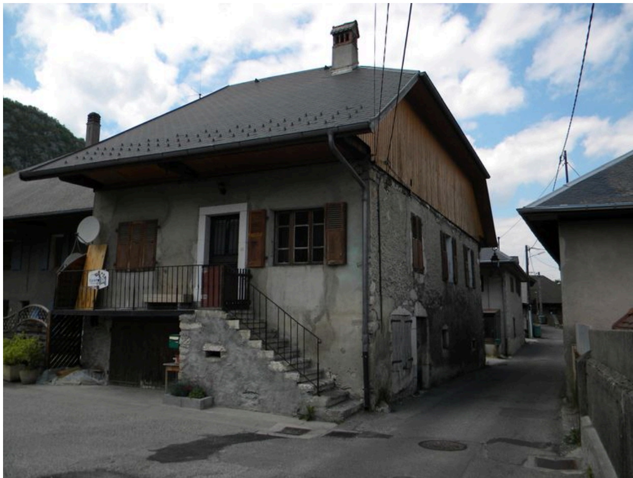
Vue générale de la ferme avec sa façade principale, et l'entrée de l'écurie sur le mur pignon.
