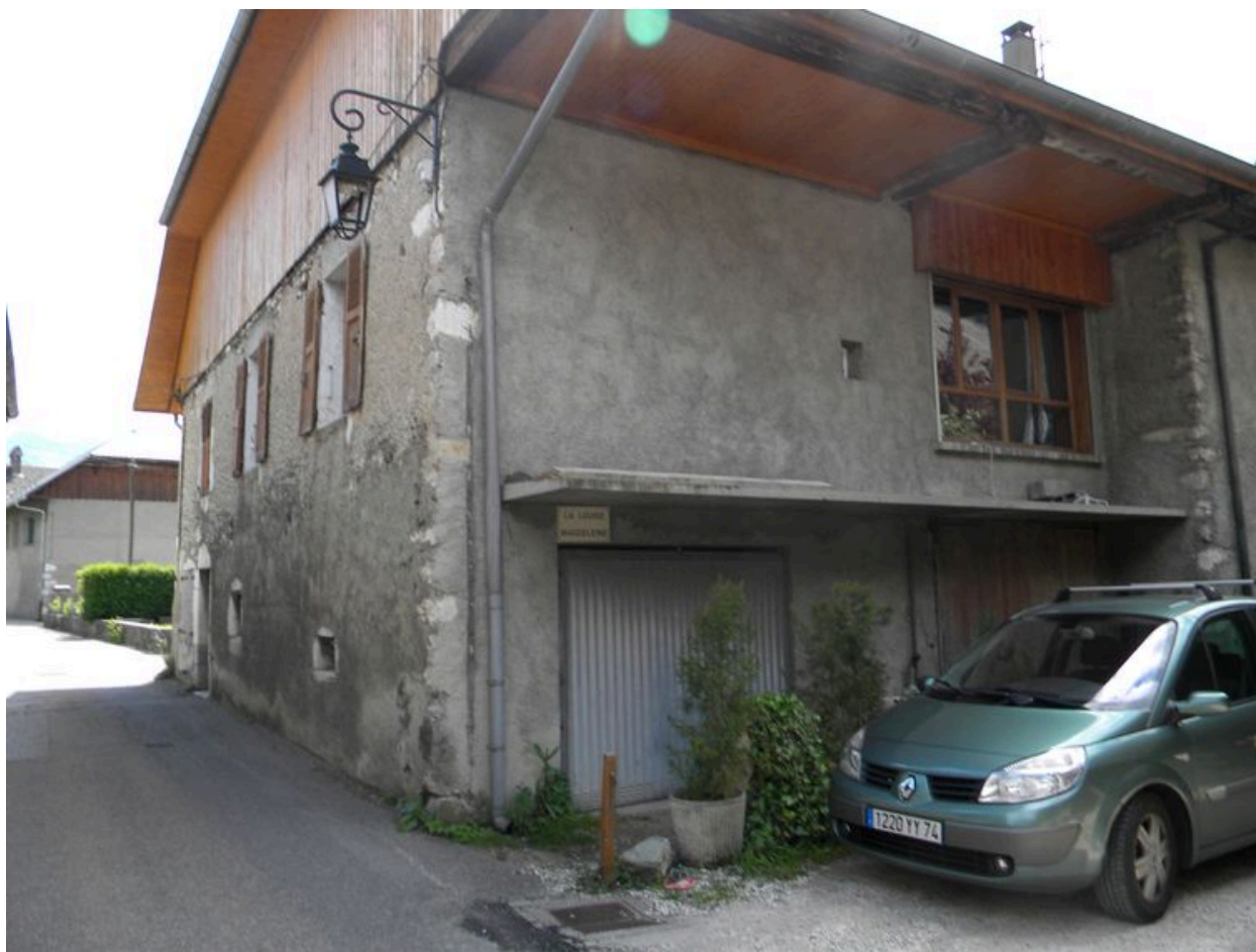
Vue de la façade arrière.
