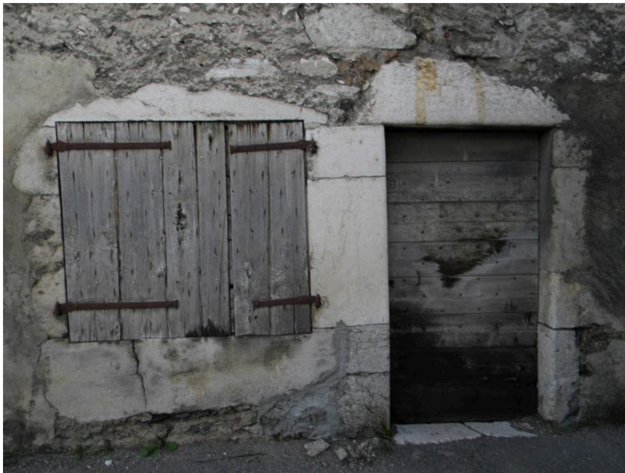
Vue de la porte d'entrée d'écurie couplée avec une fenêtre.
